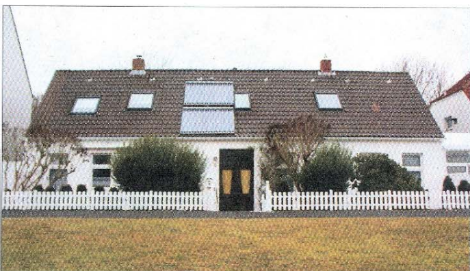
Das stark modernisierte Haus Knigge stammt aus der zweiten Baugeneration, die auf das Fischerhaus folgte.
