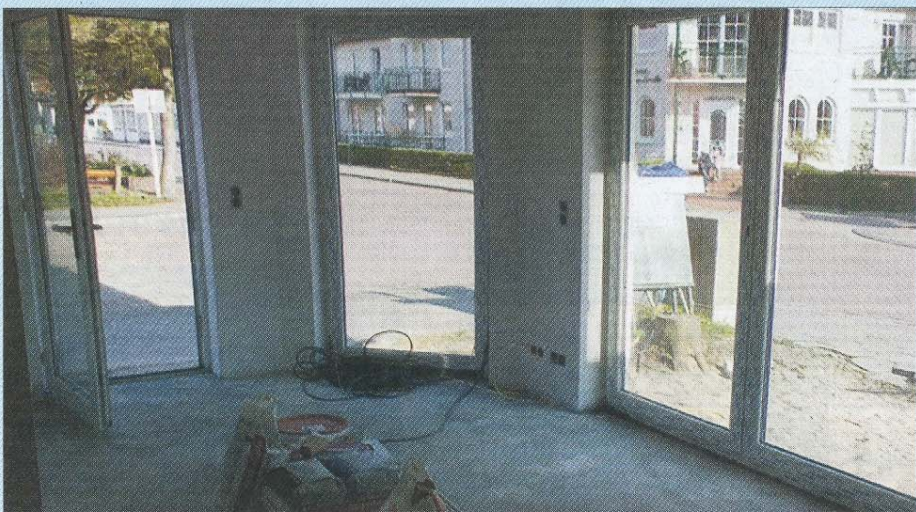
Auch der Innenausbau ging zügig über die Bühne.
