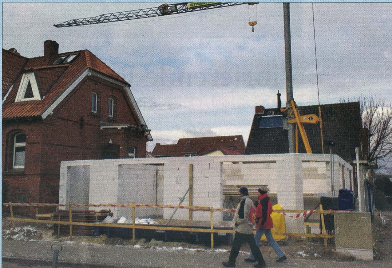
Ein rascher Baufortschritt zeichnete das Projekt aus.
