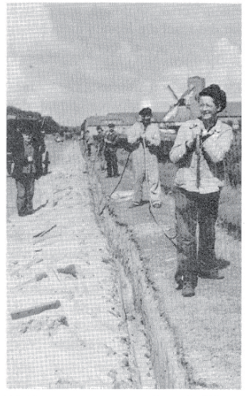
Kabelverlegung in der Mühlenstraße/Hafenstraße (1953)
