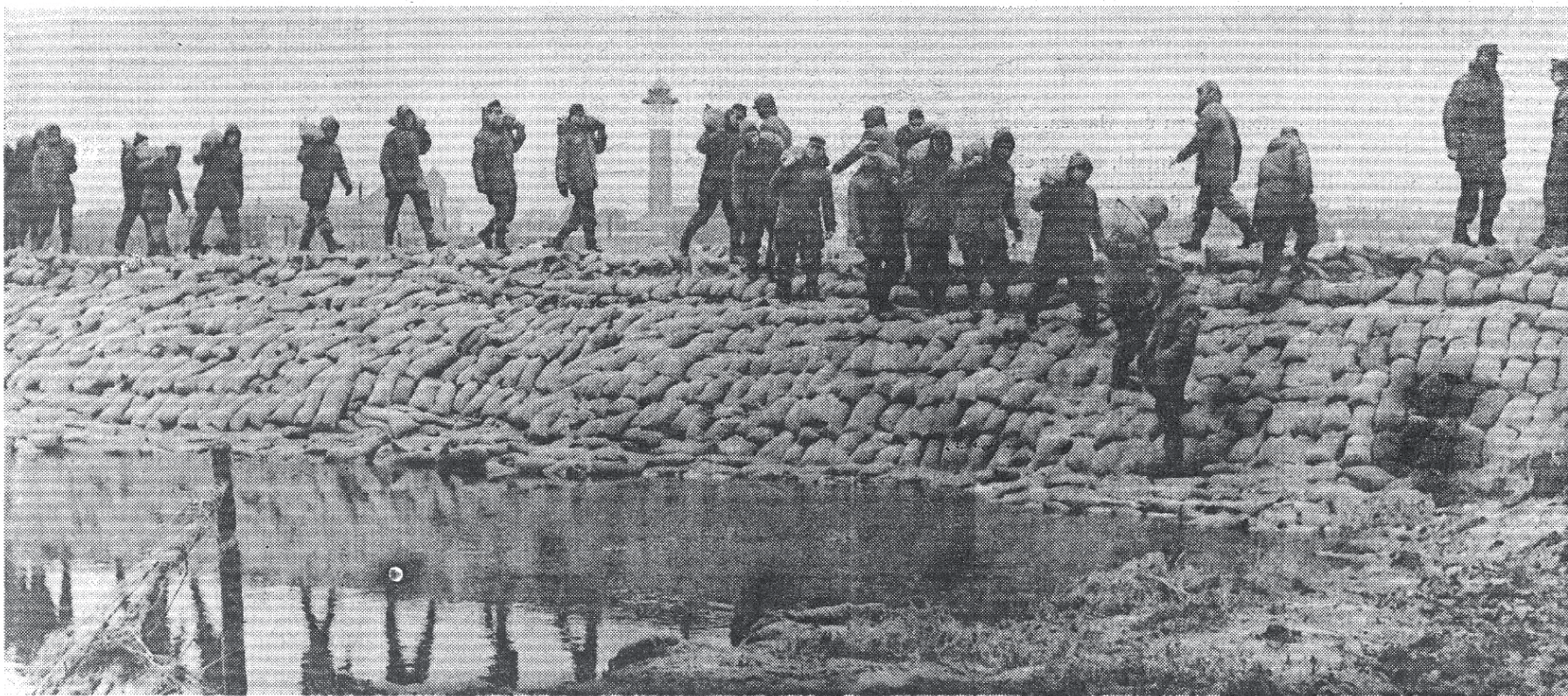
Eile tat not! Nicht nur im besonders schwer betroffenen Hamburg, an der gesamten Nordseeküste hatte der „blanke Hans“ in der Nacht zum 17. Februar Deiche und Schutzanlagen angegriffen und an zahlreichen Stellen durchbrochen. Mit Sandsäcken wurden die Lecks in den Deichen notdürftig abgedichtet, Pioniere der Bundeswehr – unterstützt von freiwilligen Helfern – schlepten stundenlang unermüdlich die Last zu den besonderen Gefahrenpunkten (Bild links). Auch bei der Rettung der Menschen aus ihren von den Wassermassen eingeschlossenen Häusern leisteten die Soldaten unschätzbare Hilfe (Bild unten). Mit Schlauchbooten drangen die Pioniere zu den Verzweifelten vor, die sich vor der unmittelbaren Bedrohung durch den „blanken Hans“ auf die Dächer ihrer Häuser oder auf Bäume gerettet hatten, und bargen sie unter Gefahr für das eigene Leben aus der Notlage. Für insgesamt 347 Menschen – davon allein 315 in Hamburg – aber kam jede Hilfe zu spät: Sie waren im Schlaf von den Wassermassen der Nordsee überrascht worden und hilflos ertrunken.
