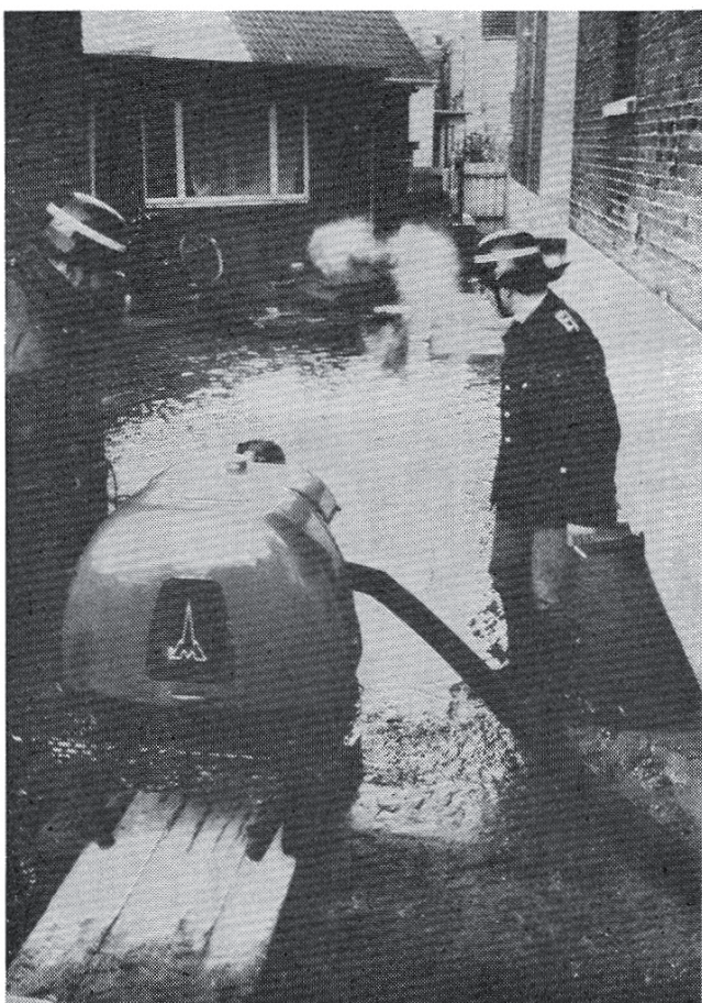
Alle verfügbaren tragbaren und mobilen Pumpen der insularen Feuerwehr stehen in pausenlosem Einsatz, um so schnell wie möglich das in das westliche Stadtgebiet eingedrungene Seewasser wieder abzupumpen. — Ölalarm gab es in einem Hinterhof der Kaiserstraße. Hier war ein 7 000 Liter fassender Heizöltank vom Wasser aus seiner Bodenverankerung aufgedrückt worden. Das ausgeflossene Heizöl wurde von der Feuerwehr mit einem Spezial-Bekämpfungspulver auf dem Wasser gebunden und unschädlich gemacht. Eine weitere Gefahrensituation entwickelte sich durch einen Gasrohrbruch, der durch die Überschwemmungsfolgen in einem Hause an der Friedrichstraße entstanden war. Auch hier konnte durch rasche Hilfe Schlimmeres verhütet werden. — Auf einer Länge von rund 45 Metern brach die obere Schrägschutzmauer vor dem Haus „Daheim“ durch Unterspülungen ein. Unsere Aufnahme zeigt die bereits wieder mit Basaltsteinen aufgefüllte Schadensstelle.
