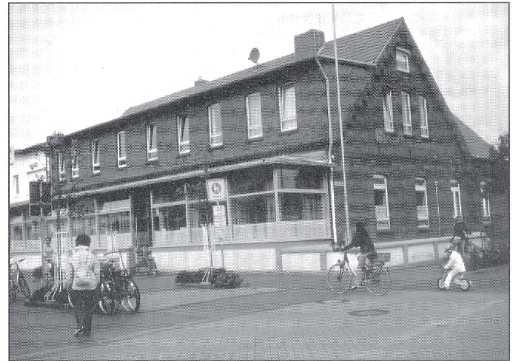
Abb.1: Das ehemalige Schullandheim Dresden vor dem Abbruch, 2008.
