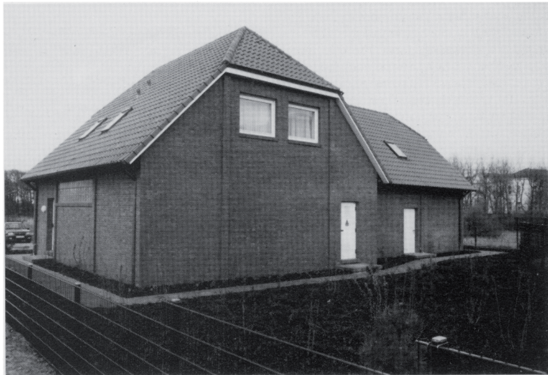
Die neue Stromübergabestation „Frisia“
