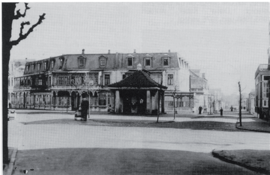
Trafostation auf dem Onnen-Visser-Platz um 1940
