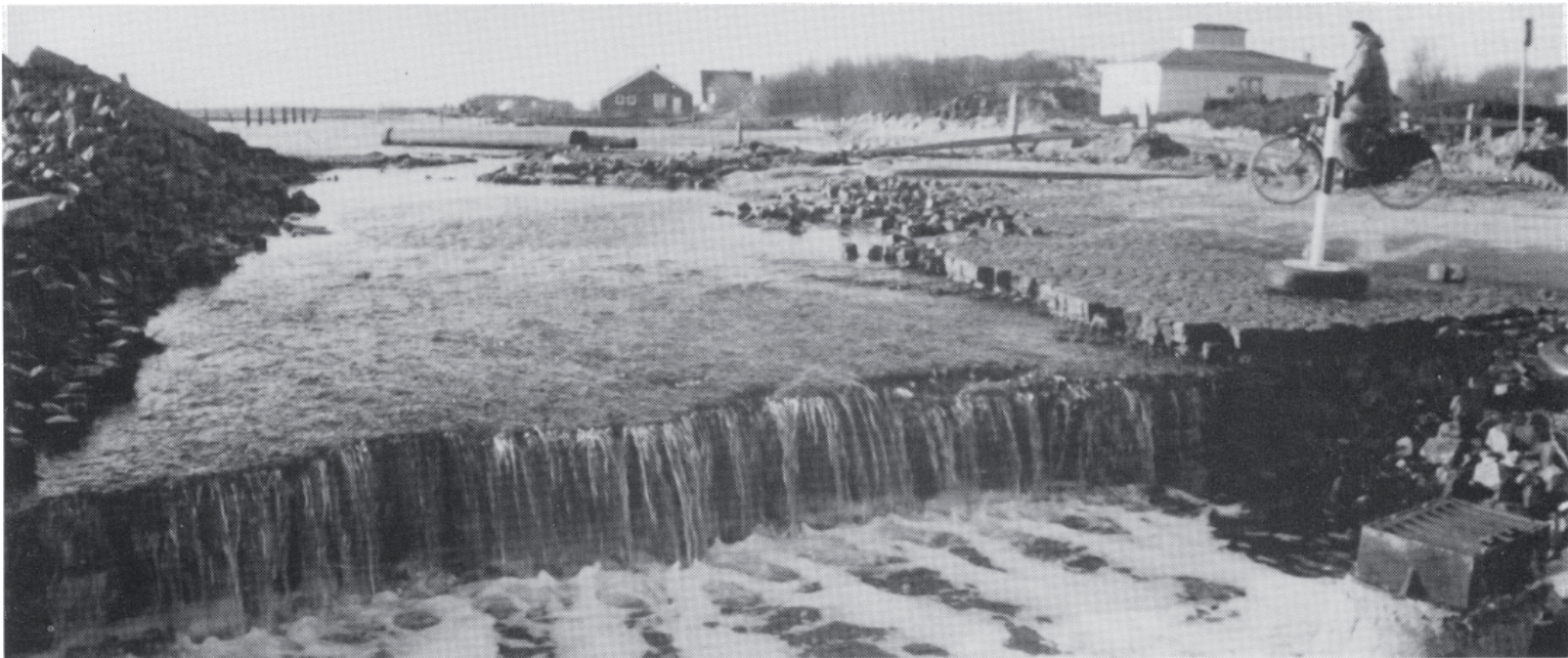
Zur Ableitung der Wassermassen ist die Hafenstraße durchbrochen worden
