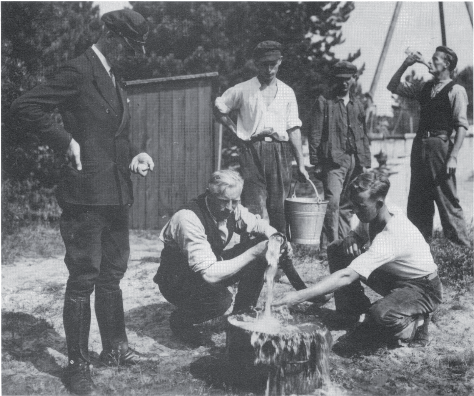
Brunnenbau — Von links: Betriebsingenieur Friedrich Müller, Wassermeister Sieben Sieberns und Eve Schollmann (beide knieend), Johann Rass (mit dem Eimer), ?, Heinrich Sieberns
