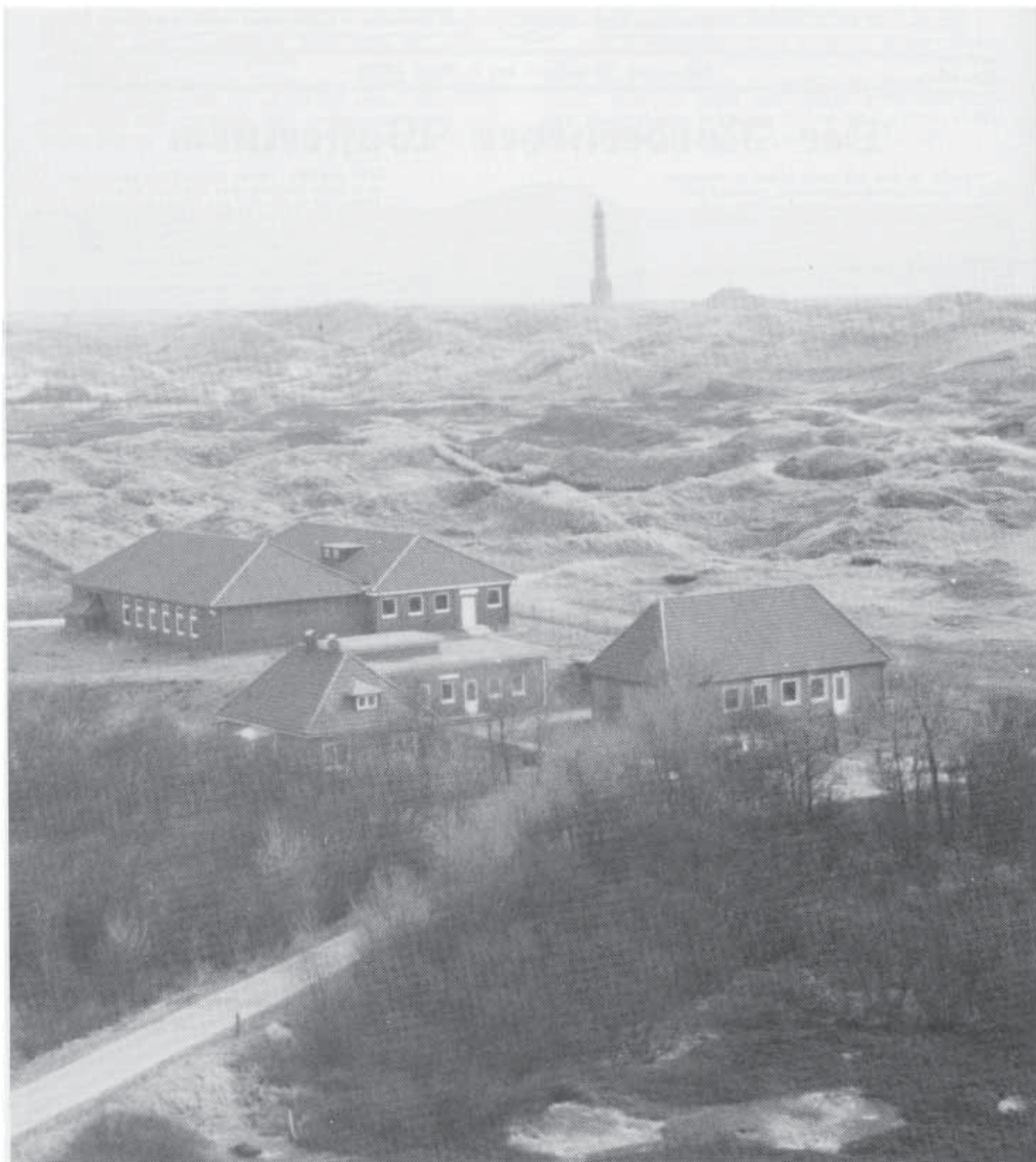
Wasserwerk „Weiße Düne“ (II)
