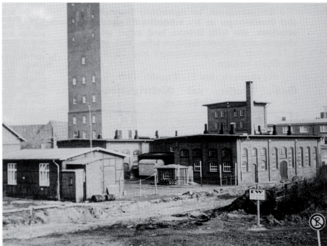
Der Norderneyer Schlachthof — Stromübergabestation von 1914 bis 1953
