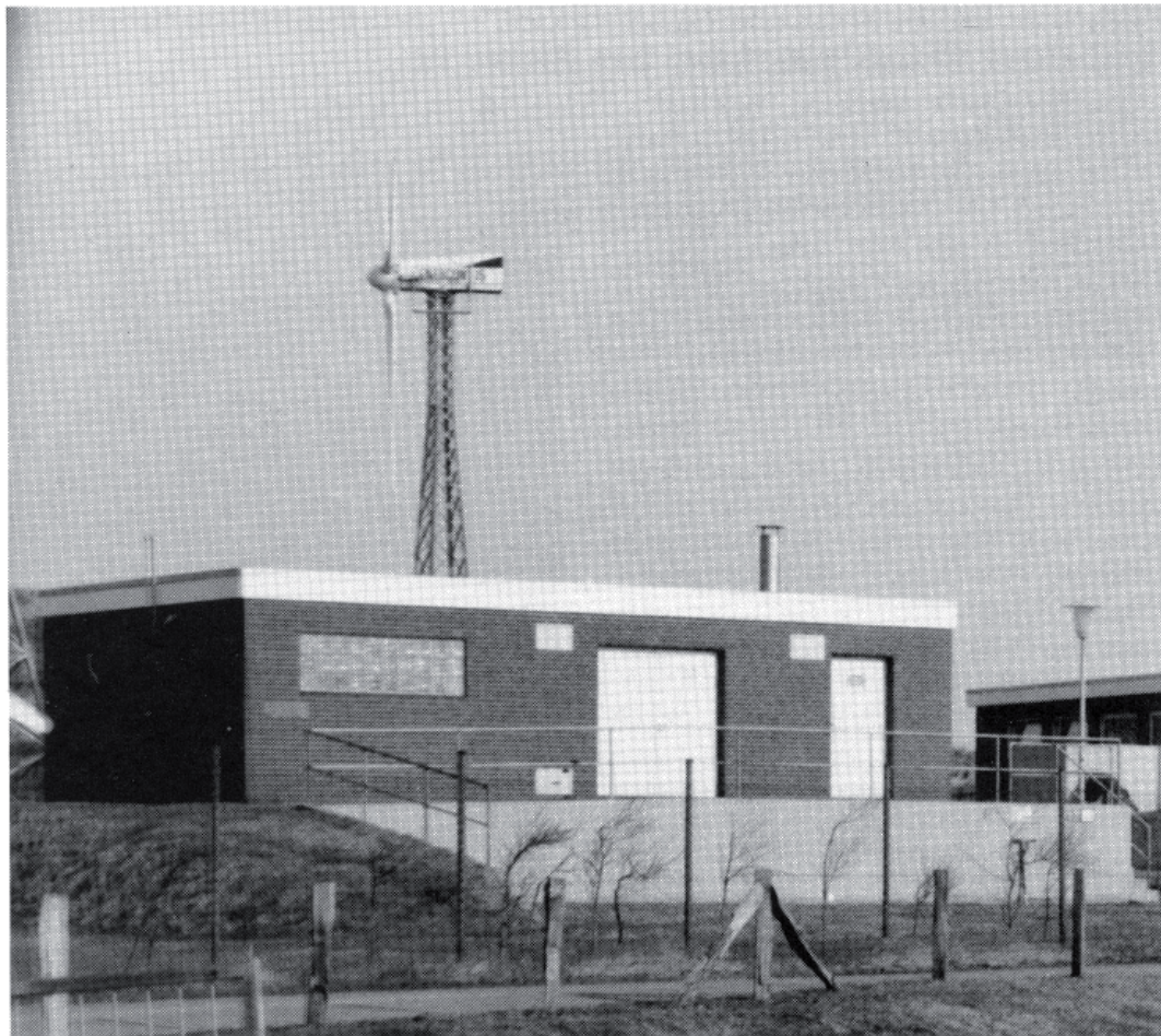
Die 1981 neuerbaute Gasübergabestation
