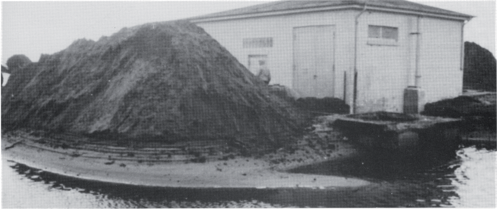
Sturmflut, Februar 1962 - Die vom Wasser bedrohte Stromübergabestation „Frisia“
