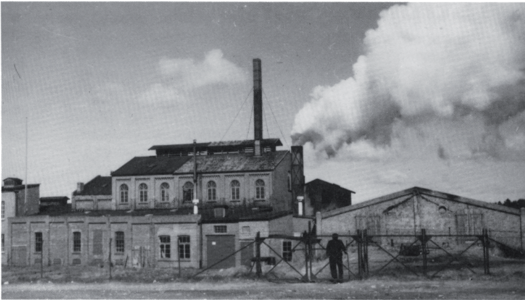
Gaswerk (Südansicht) Von links: Kühlturm, Ofenhaus, Kohlenschuppen
