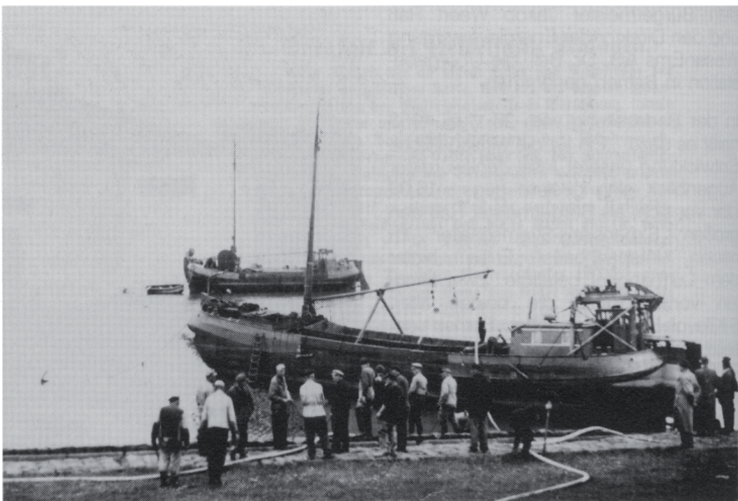
Kabelverlegung durch das Wattengebiet
