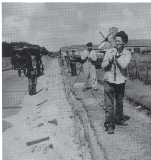
Kabelverlegung in der Mühlenstraße/ Hafenstraße (1953)
