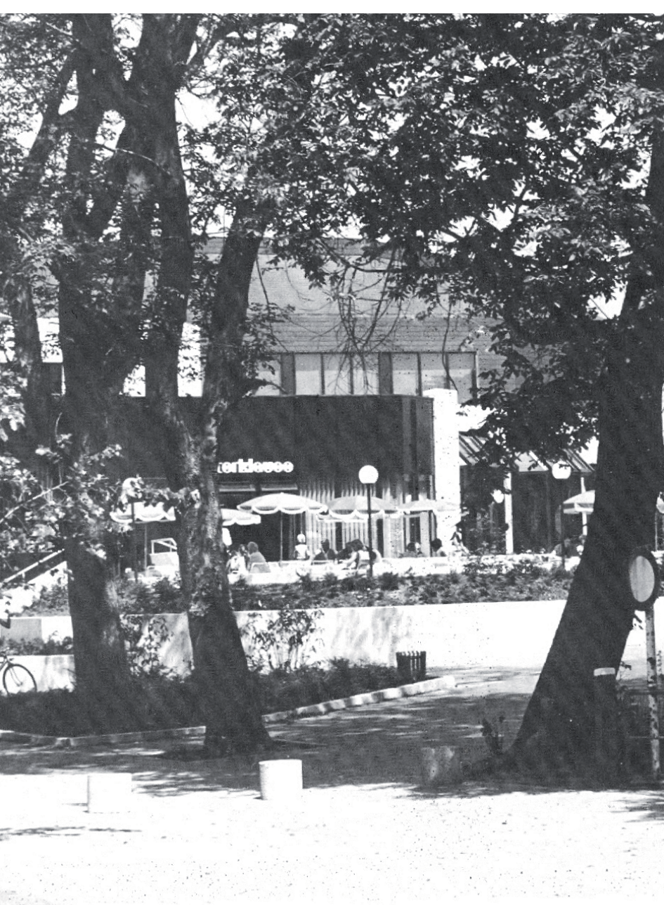
Blick zur Theaterklaus
