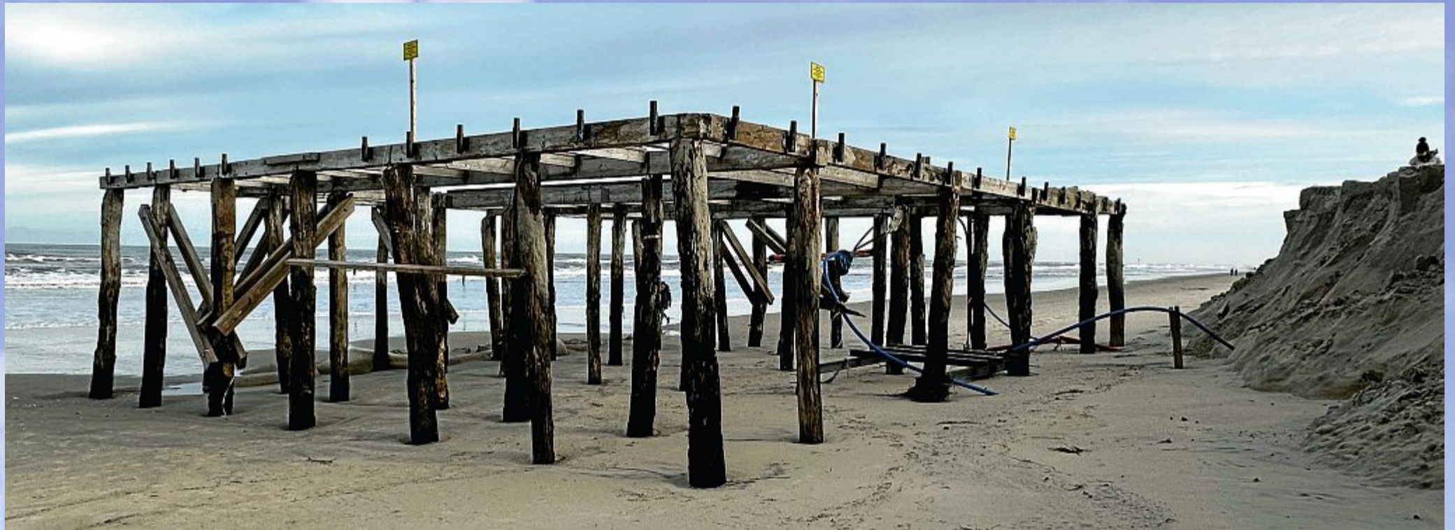
Inzwischen steht das Gerüst an der Weißen Düne wieder komplett frei und das Strandniveau ist drastisch gesunken.
