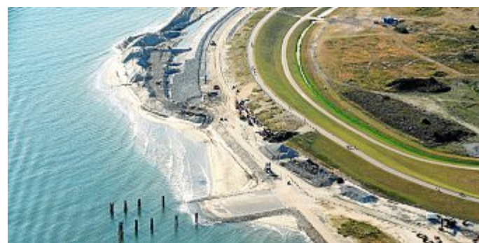
Inzwischen ist der Deich am Weststrand erneuert.
