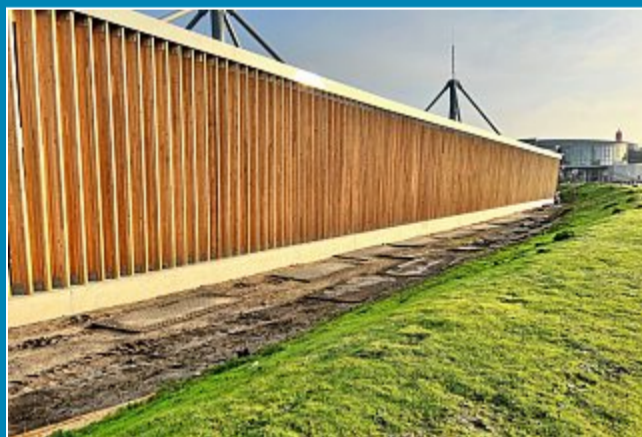
Der Windschutz der Fahrradabstellanlage ist fertig.
