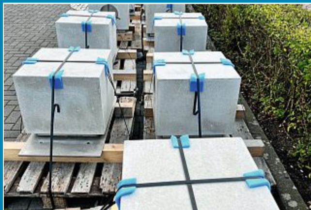
Die neue Beleuchtung der Promenade ist angekommen. Inzwischen werden die Würfel installiert. Das Licht soll grünlich sein.
