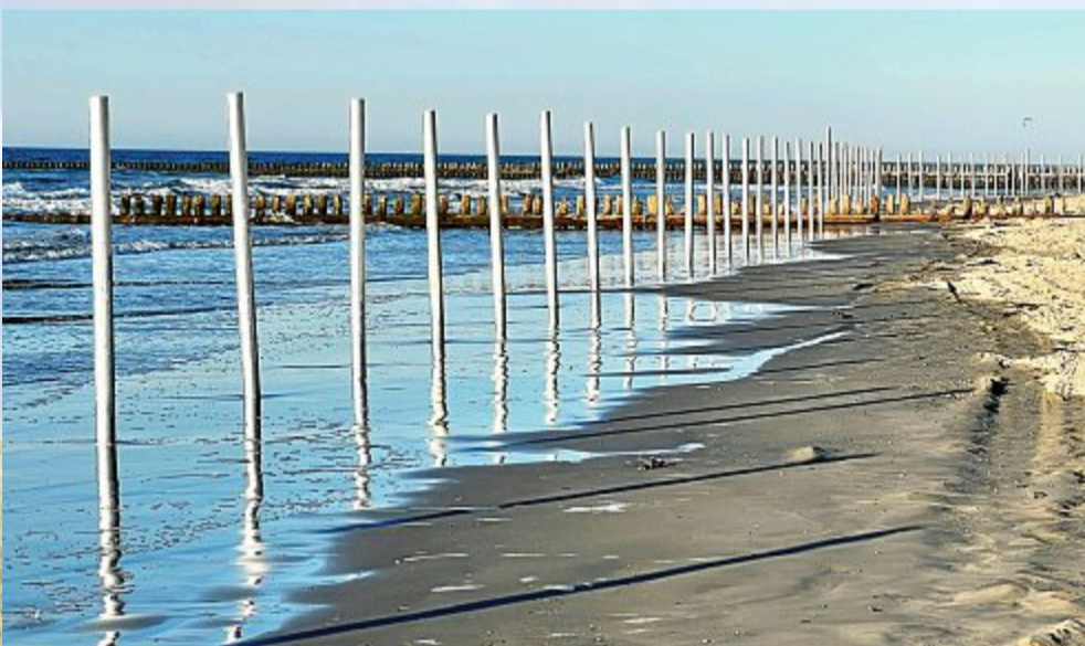
Absperrungen sollen Unfälle verhindern.
