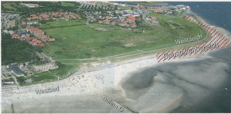
Etwa 400 Meter lang ist der neue Bauabschnitt und erstreckt sich bis zum Anleger.
