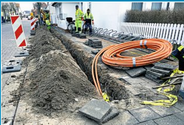
NyNET gibt Gas. Die Verlegung der Kabel geht mit schnellen Schritten voran.
