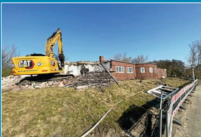
Das Gruko-Gebäude wird abgerissen.
