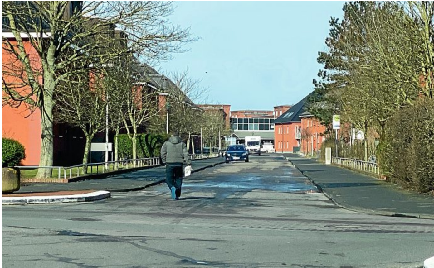
Die nördliche Mühlenstraße soll schöner und klimafreundlicher werden.
