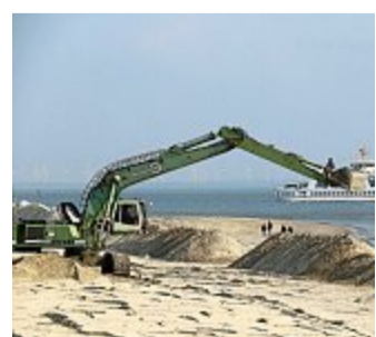
Baumaßnahmen laufen an.
