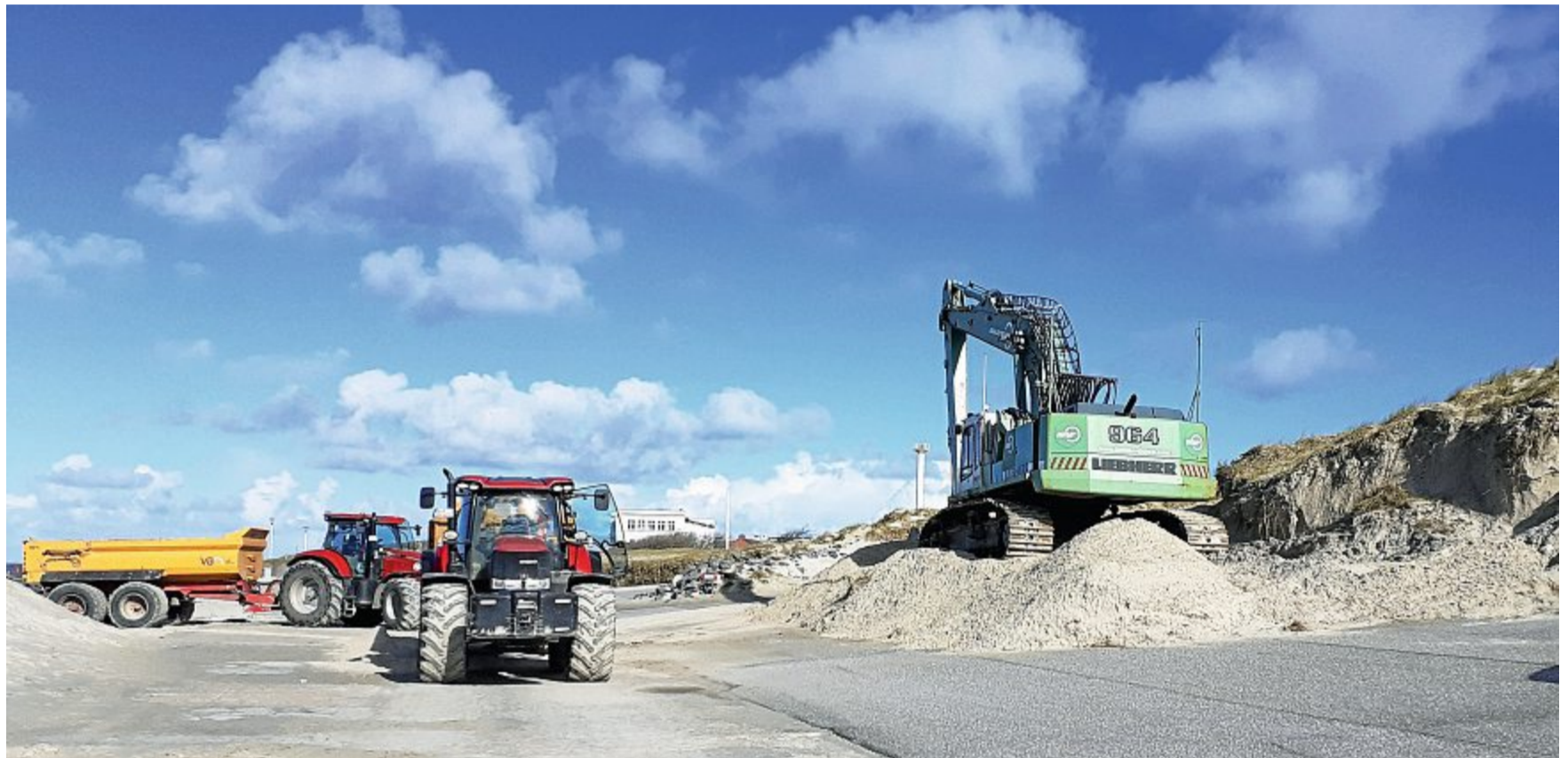
Die Arbeiten am Weststrand. Allein 8000 Tonnen an Wasserbausteinen müssen bewegt werden.
