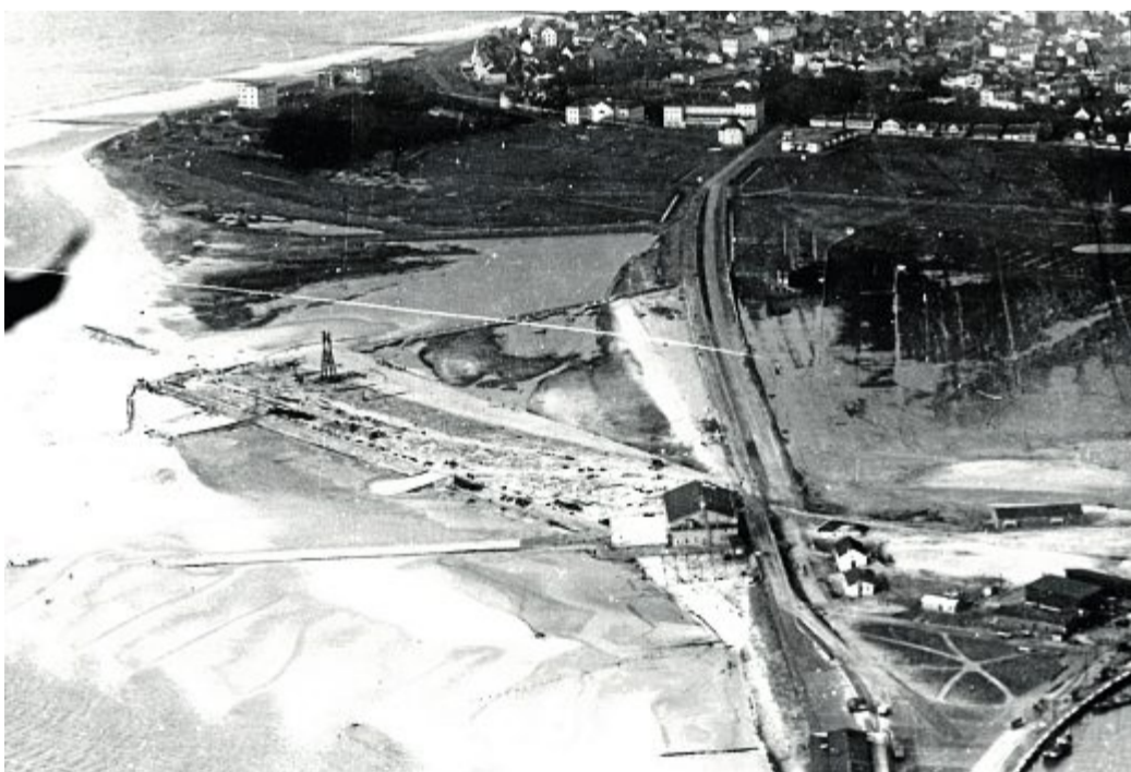
Luftbild mit der Baustelle der Seeflugstation, 1915/1916. In der Mitte die Hafenstraße (heute Habenpad), südlich davon ein 300 x 300 Meter großes Areal der Baustelle. Vorn der im Herbst 1914 errichtete Flugzeugschuppen mit der Ablaufbahn. Im noch nicht mit einer Betonmauer geschützten Uferbereich im Anschluss an das Baugelände befinden sich noch Dünen, Heller, Verlandungs- wie auch unbewachsene Überflutungsbereiche.
