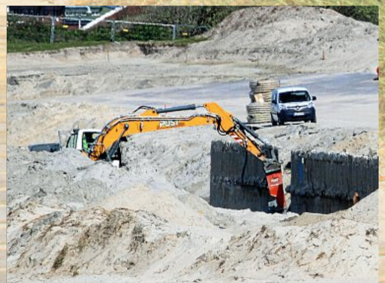
Die vertikale Betonwand wird abgetragen.
