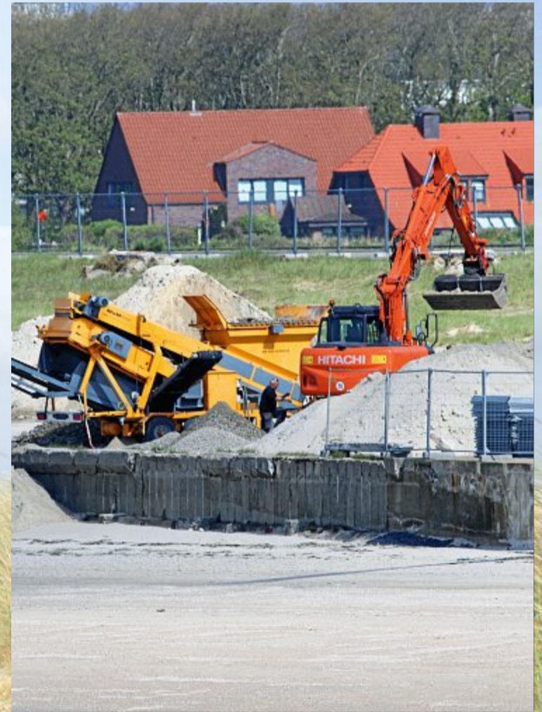
Der anfallende Sand wird gesiebt...
