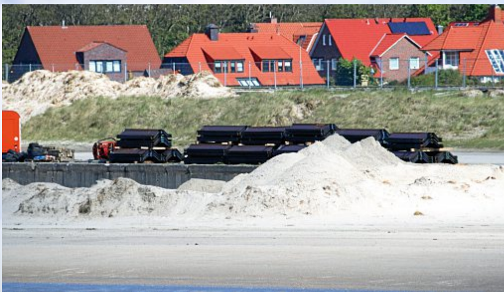
Die neuen, tonnenschweren Spundwände liegen schon bereit.
