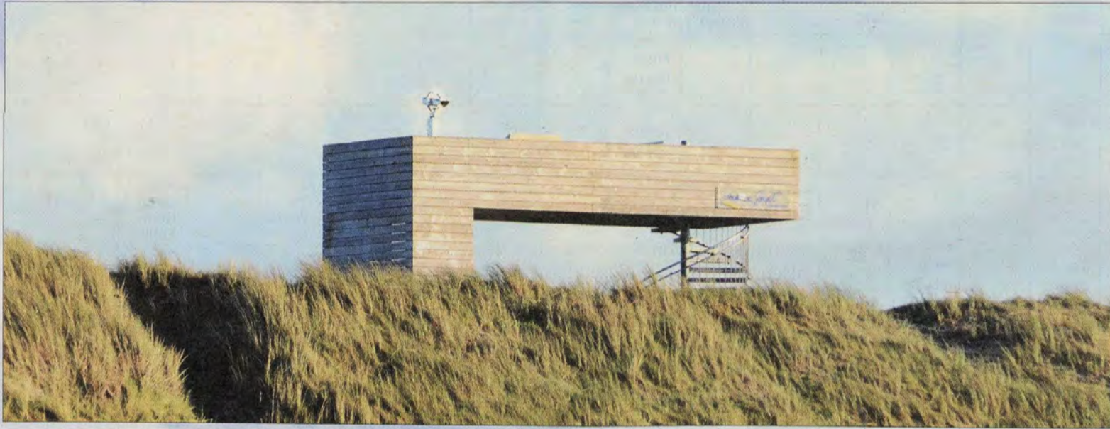
Gerade Linien gelten als nicht natürlich. Die Aussichtsplattform fügt sich trotzdem in die Dünenlandschaft ein.
