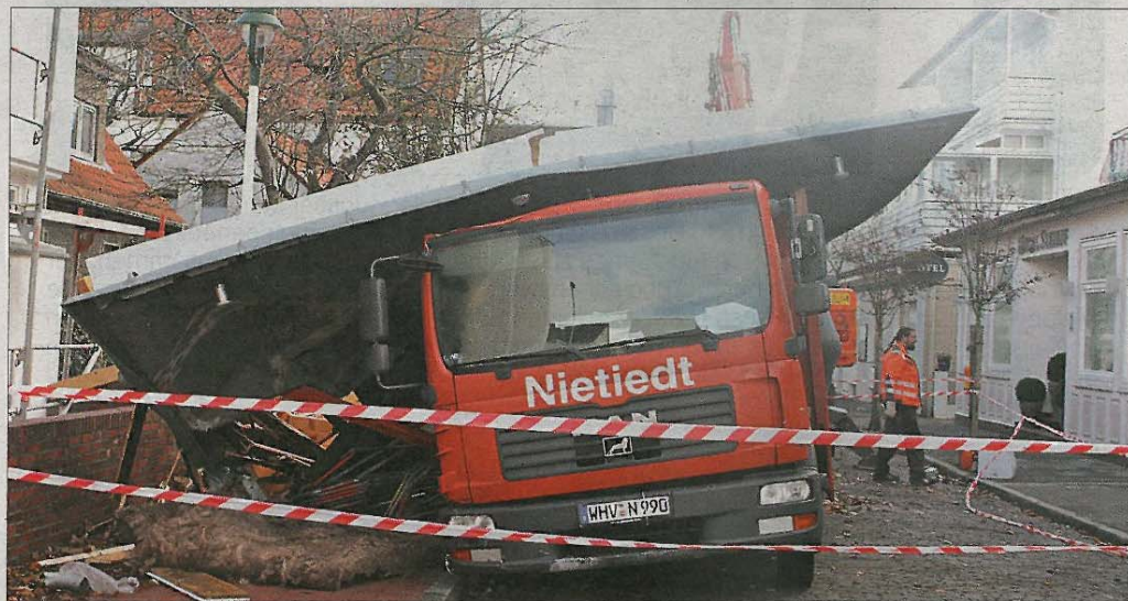
In der Goebenstraße landete ein ganzes Dachstück auf einem parkenden Lastwagen. Dies ist nur eine der vielen Stellen, die von den Einsatzkräften abgesperrt werden mussten.
