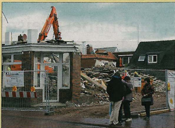
Die Großbaustelle an der Ecke Winterstraße/Jann-Berghaus-Straße. FOTOS: ENGEL
