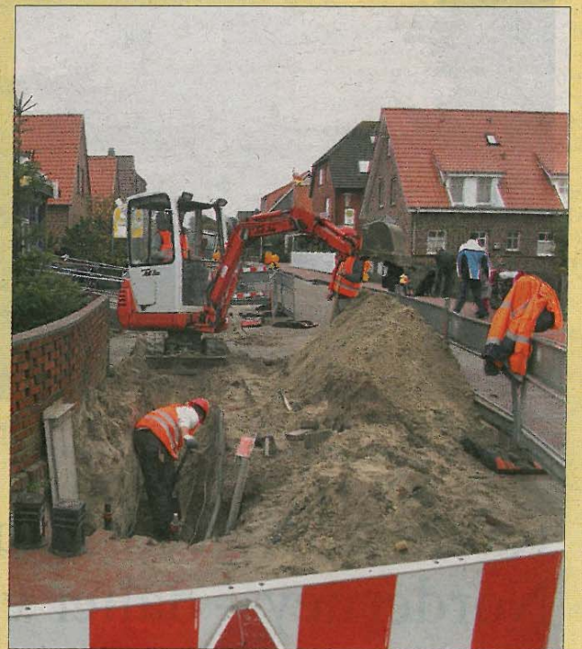
Auch in der Nordhelmsiedlung wird gebuddelt – hier an den Versorgungsleitungen. FOTO: HAHLBOHM
