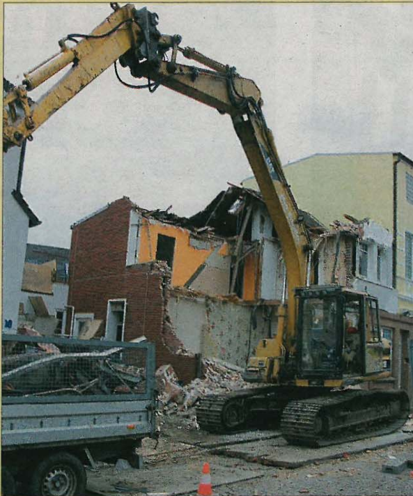
Gegenüber der Inselkirche in der Kampstraße wird mit schwerem Gerät gearbeitet.
