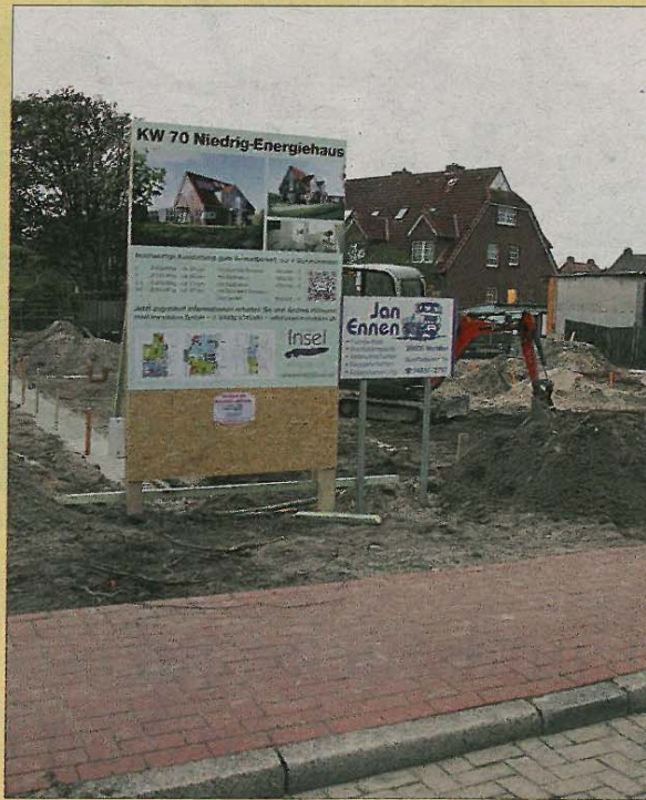
Abreißen und mit energieeffizienter Ausstattung neu errichten: Baustelle im Birkenweg.
