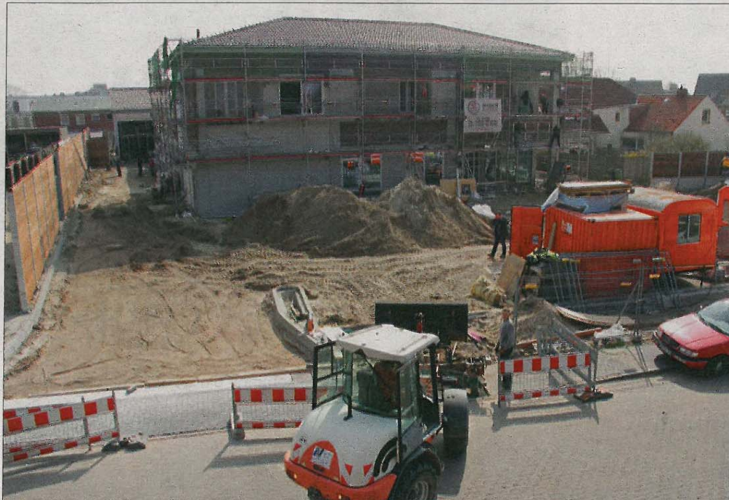
Noch ist der von hohen Schutzwänden eingerahmte Neubau für den Netto-Markt an der Bürgermeister-Willi-Lührs-Straße eine riesige Baustelle. FOTO: NEYPIX
