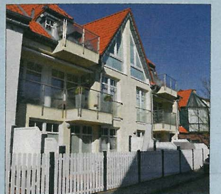
Auch in diesem Mehrfamilienhaus funktionieren Licht und Strom.
