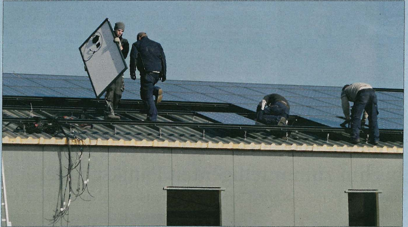
Fachleute in Sachen Energieeffizienz: Hier wird die Fotovoltaik-Anlage auf der firmeneigenen Halle installiert.
