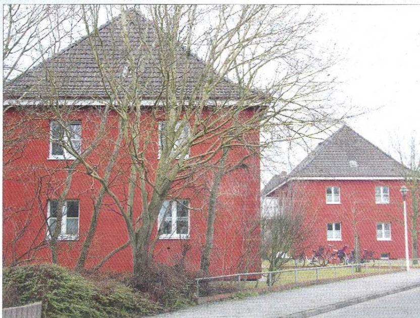
Auch die Häuser in der Jann-Berghaus-Straße wurden in naher Vergangenheit energieeffizient saniert.
