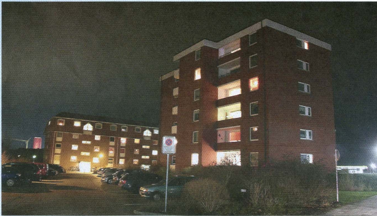
In den 1970er-Jahren wurde die Lüttje Legde durch die Neue Heimat errichtet. Mit dem Kaufvertrag aus dem Jahr 1988 gingen 225 Wohnungen in das Eigentum der WGN über.
