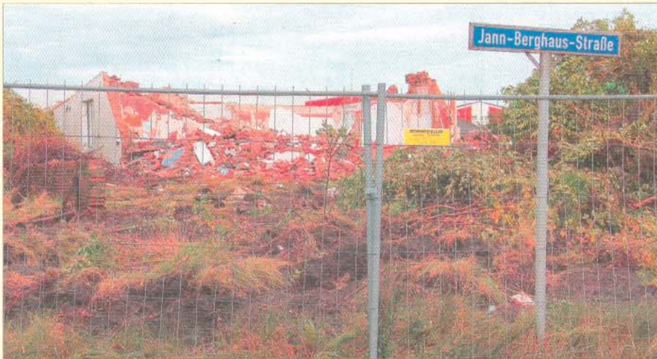
Das Eckhaus zur Bürgermeister-Willi-Lührs-Straße ist abgerissen. Dort entsteht ein Netto-Markt.
