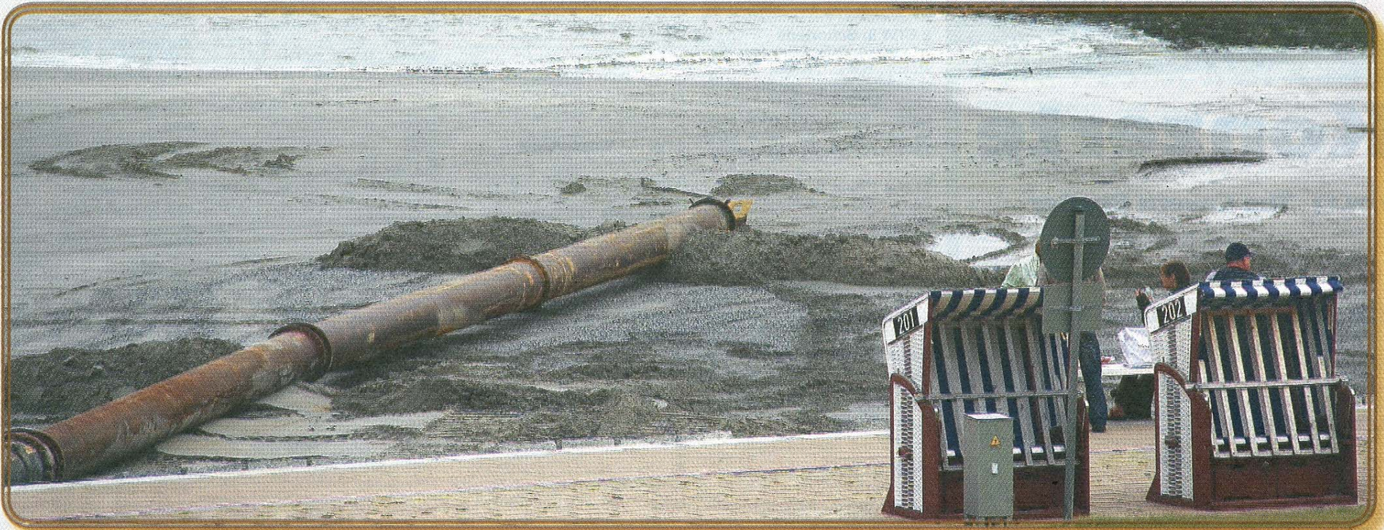
Die Rohre sind verlegt. Es kann losgehen.
