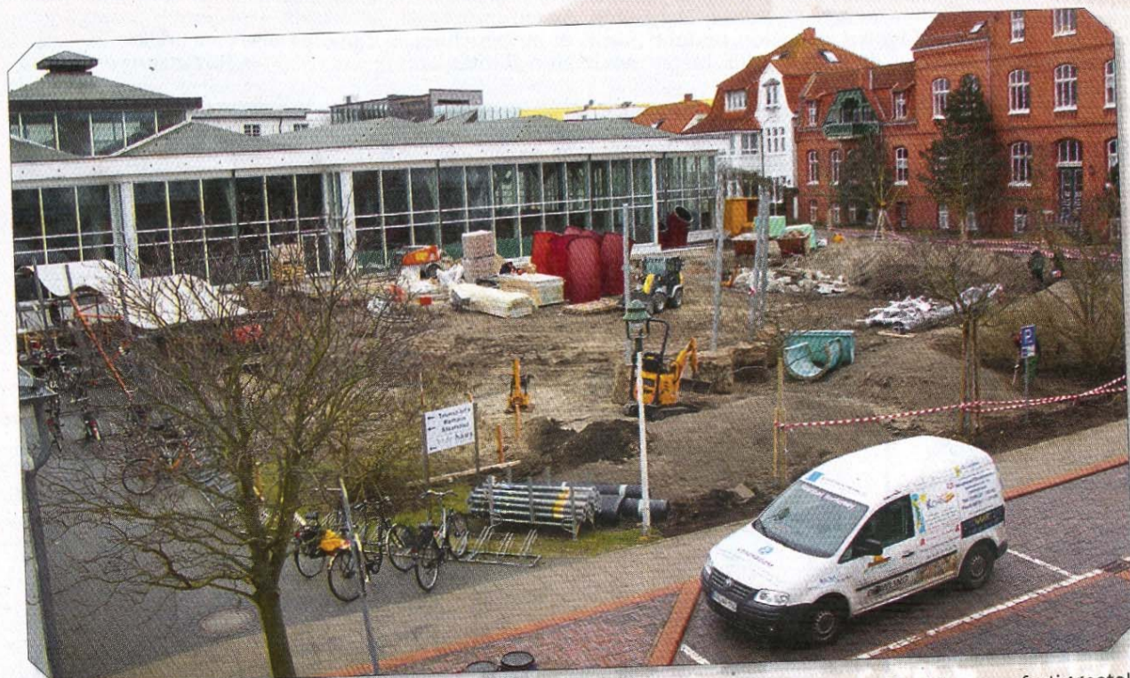
Nur schwer vorstellbar, dass hier in ungefähr einem Vierteljahr der neue Bereich des Badehauses fertiggestellt sein soll.
