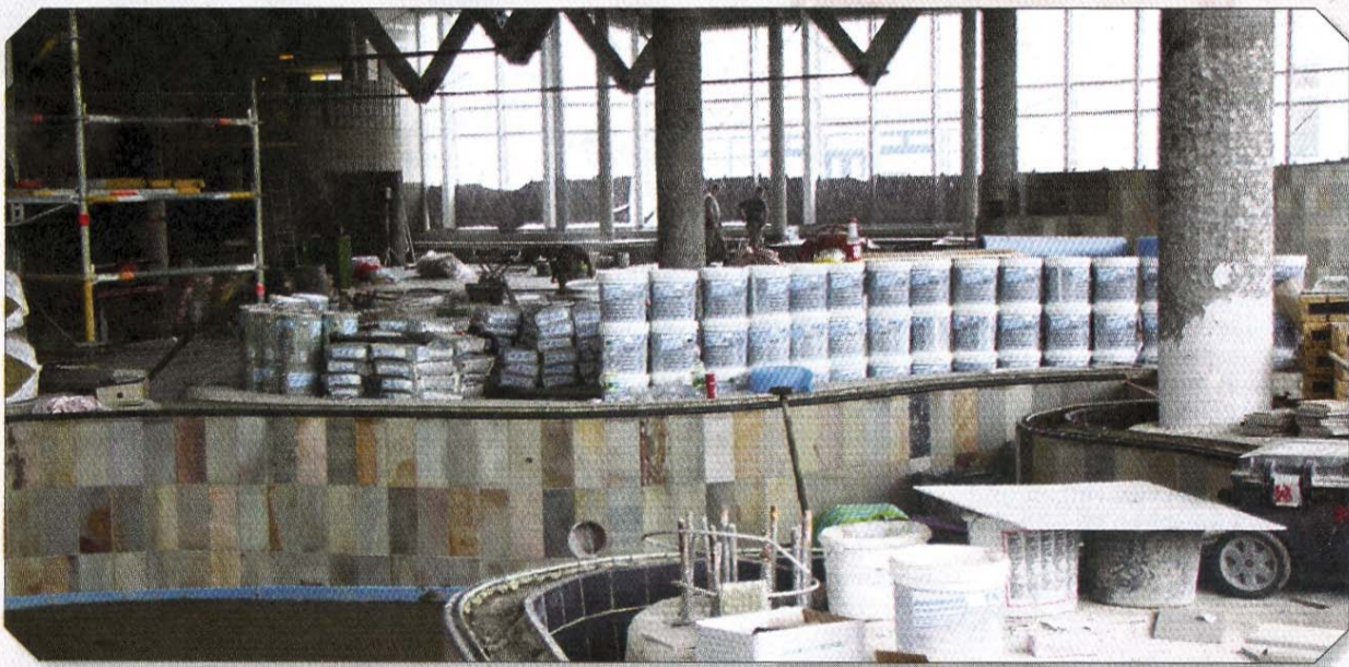
Säcke- und eimerweise Fliesenkleber und Zement für die Neugestaltung des ehemaligen Spaßbades.
