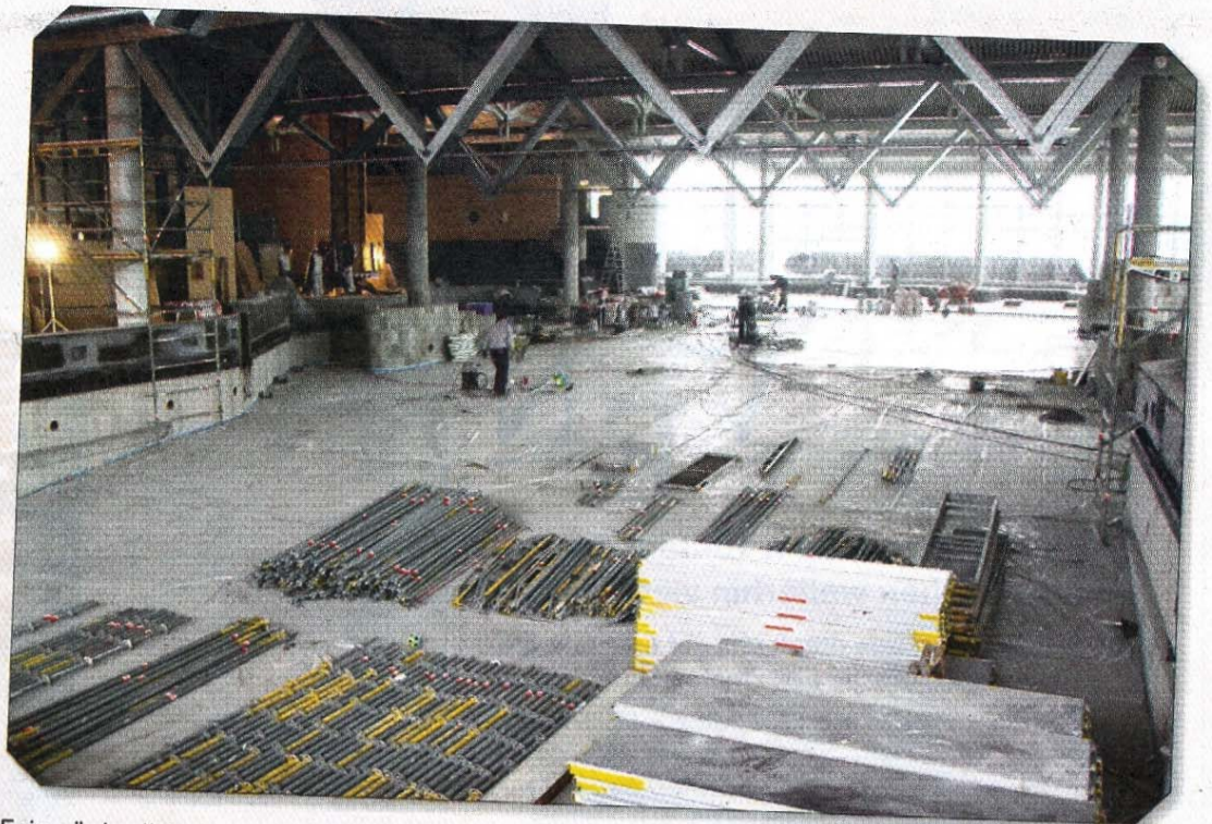
Fein säuberlich sortiert liegen die Gerüst-Einzelteile auf dem Boden des Schwimmbades.
