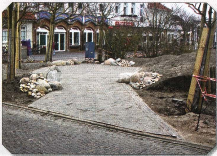
Im Außenbereich des einstigen Georgsgartens sind schon erste Fortschritte erkennbar.
