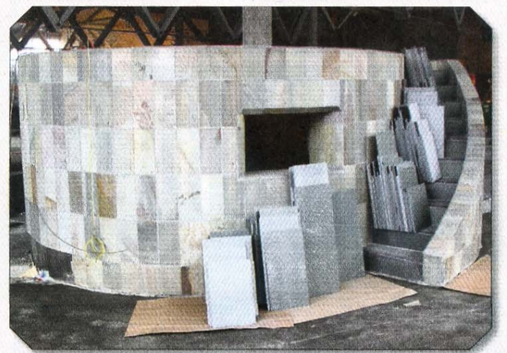
Fliesen-Domino auf der Treppe der ehemaligen Grotte.
