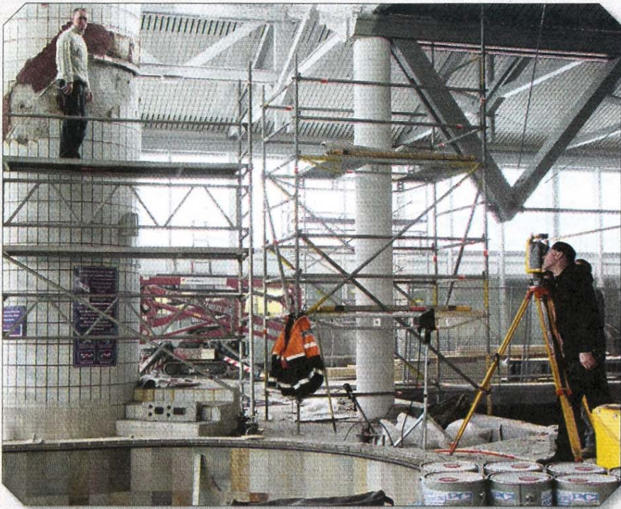
Der Standort der neuen Wasserrutsche wird exakt ausgemessen.
