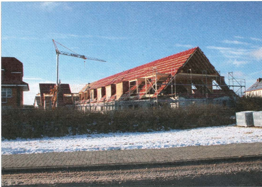
Die ehemalige sogenannte „Wilbers-Baracke“ bekommt ein neues Dach.
