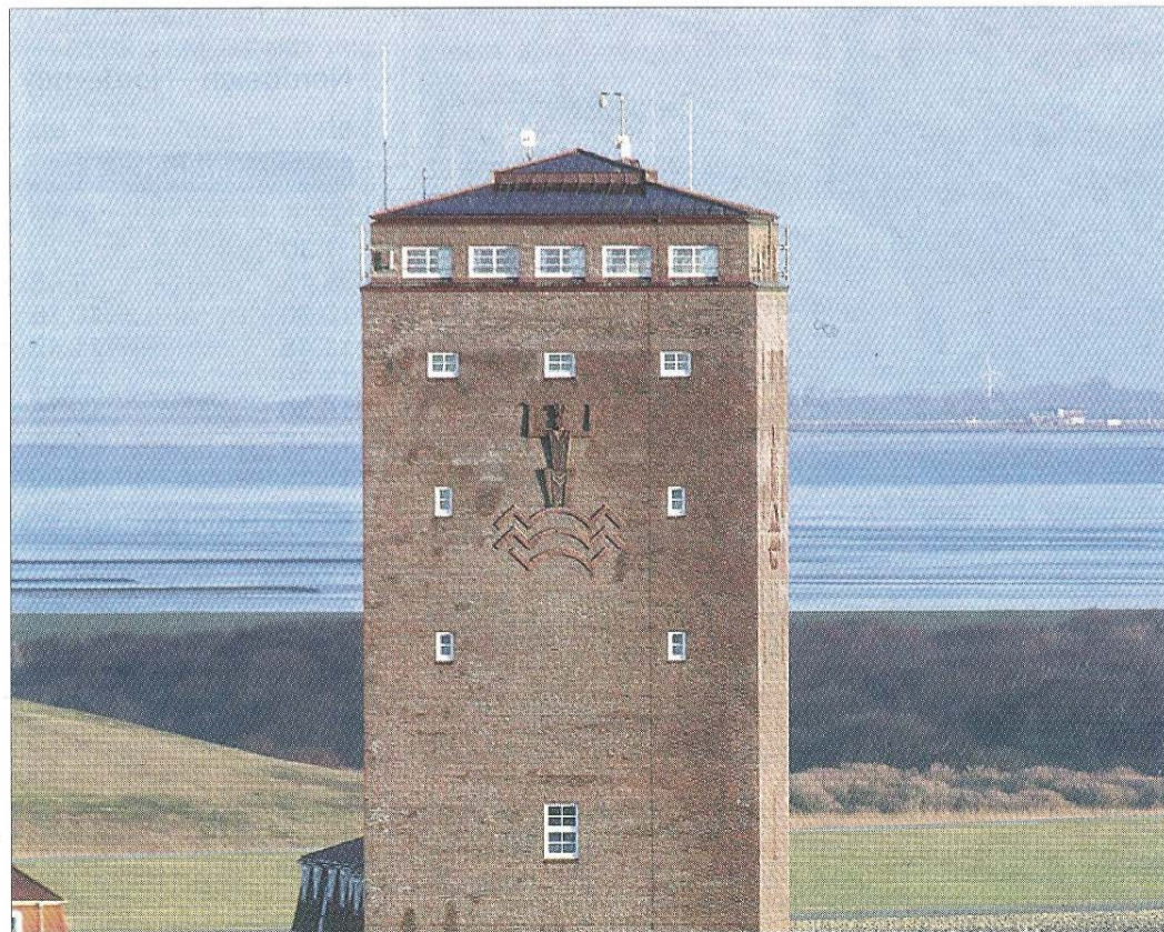
Die Antennen auf dem Norderneyer Wasserturm sind fit für den Digitalbetrieb.
