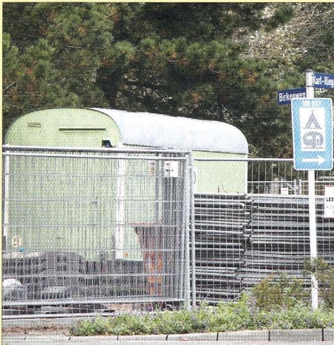
Container für die Verlegung der Versorgungsleitung in der Mainstraße stehen am Bahnhof Stelldichein.
