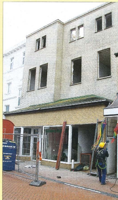
Das Haus in der Friedrichstraße wird für den Abriss vorbereitet.
