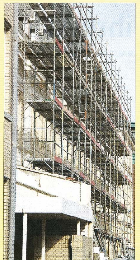
Umfassende Gerüste verkleiden manche Fassade.
