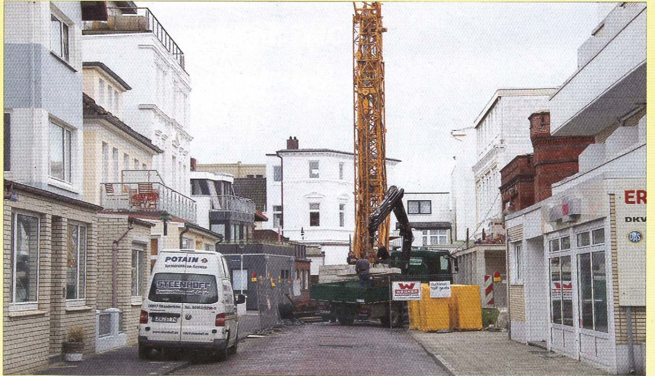
Die Bauarbeiten am „Alt Bayern“ in der Heinrichstraße (rechts) werden jetzt fortgesetzt.
