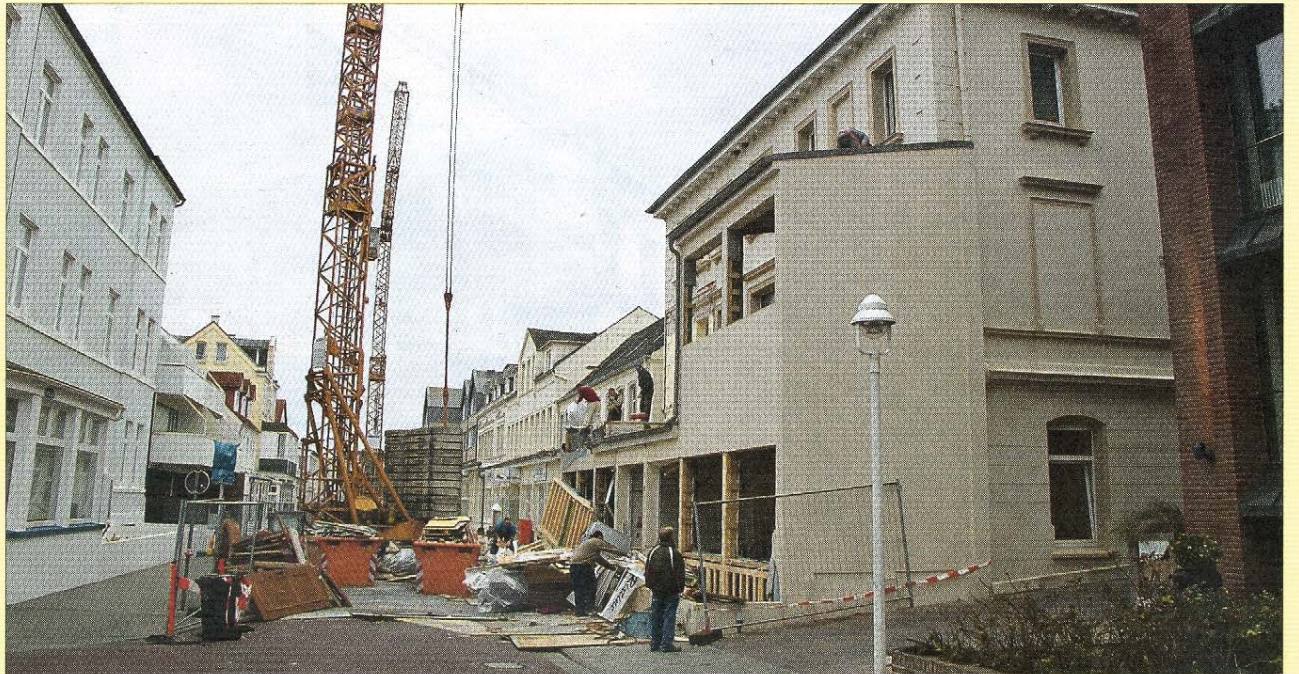
Anfang Oktober haben die Bauarbeiten am Damenpfad begonnen.
