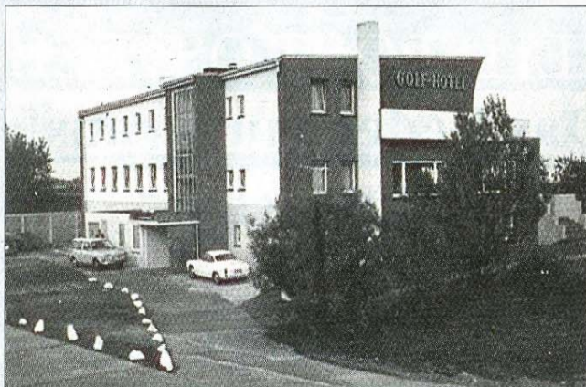
1963: vorletzter Ausbauabschnitt. 1986/87 Hotelerweiterung mit Schwimmbadbau, großer Terrasse und Bierstube.
