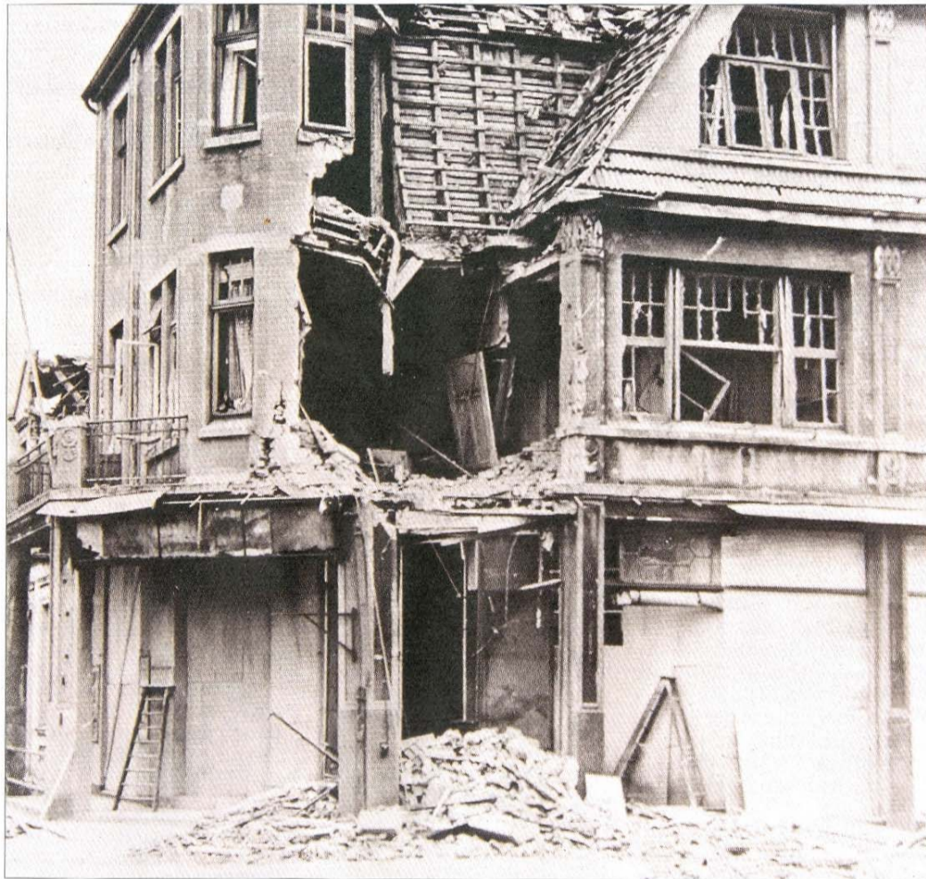
Das Foto zeigt eine Szene nach einem Bombenangriff am 10. April 1941 auf das Gebäude C. C. Valentien in der Jann-Berghaus-Straße. Vor dem Bombeneinschlag hatte ein Damenkränzchen für kurze Zeit wegen Besichtigung eines neuen Gasherdes das Zimmer verlassen, als die Bombe einschlug. Malermeister Johann Rass, der sich unten am Eingang befand, wurde schwer verletzt.
