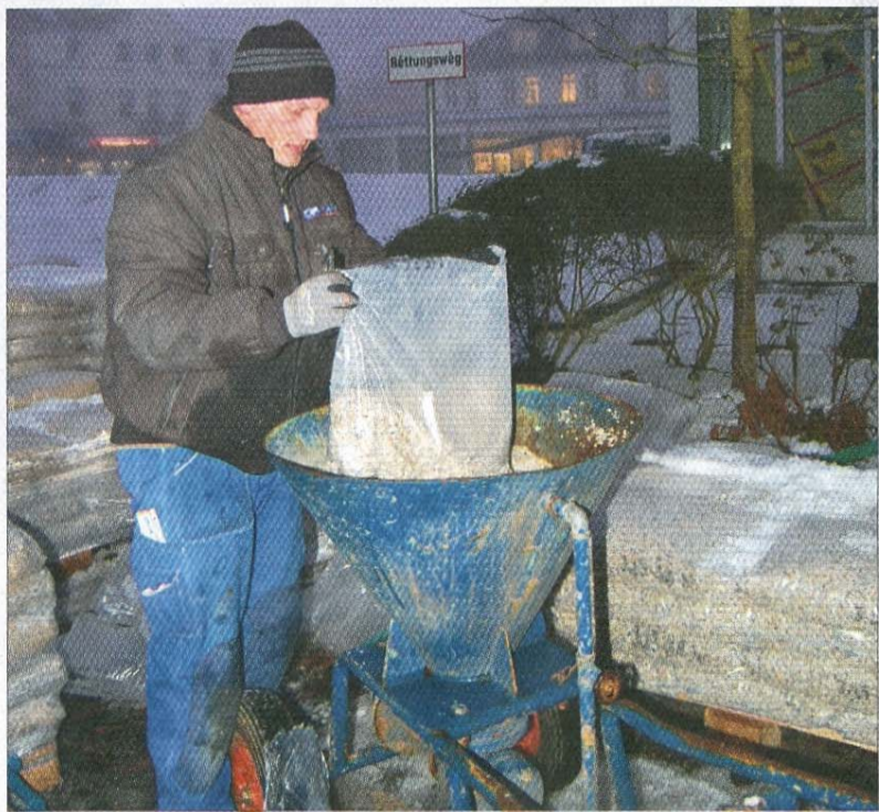
Über eine Trichtermaschine wurden in den vergangenen Wochen insgesamt 53 Tonnen Kies für die Filteranlage ausgewechselt.
