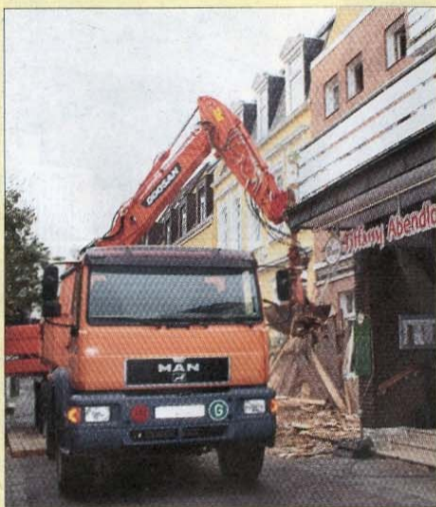
In der Kirchstraße rückte der Greifarm zu Abrissarbeiten an.
