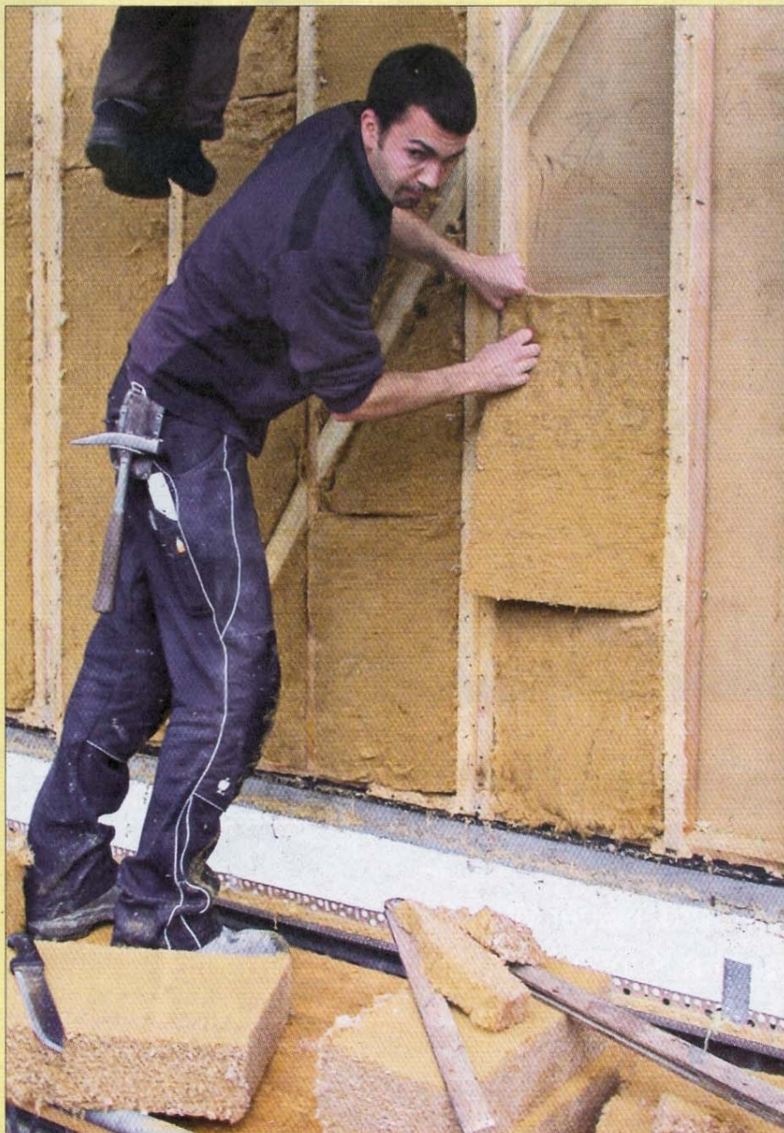
Eine Rundumdämmung sorgt für zeitgemäße Energieeffizienz im Altbau.
