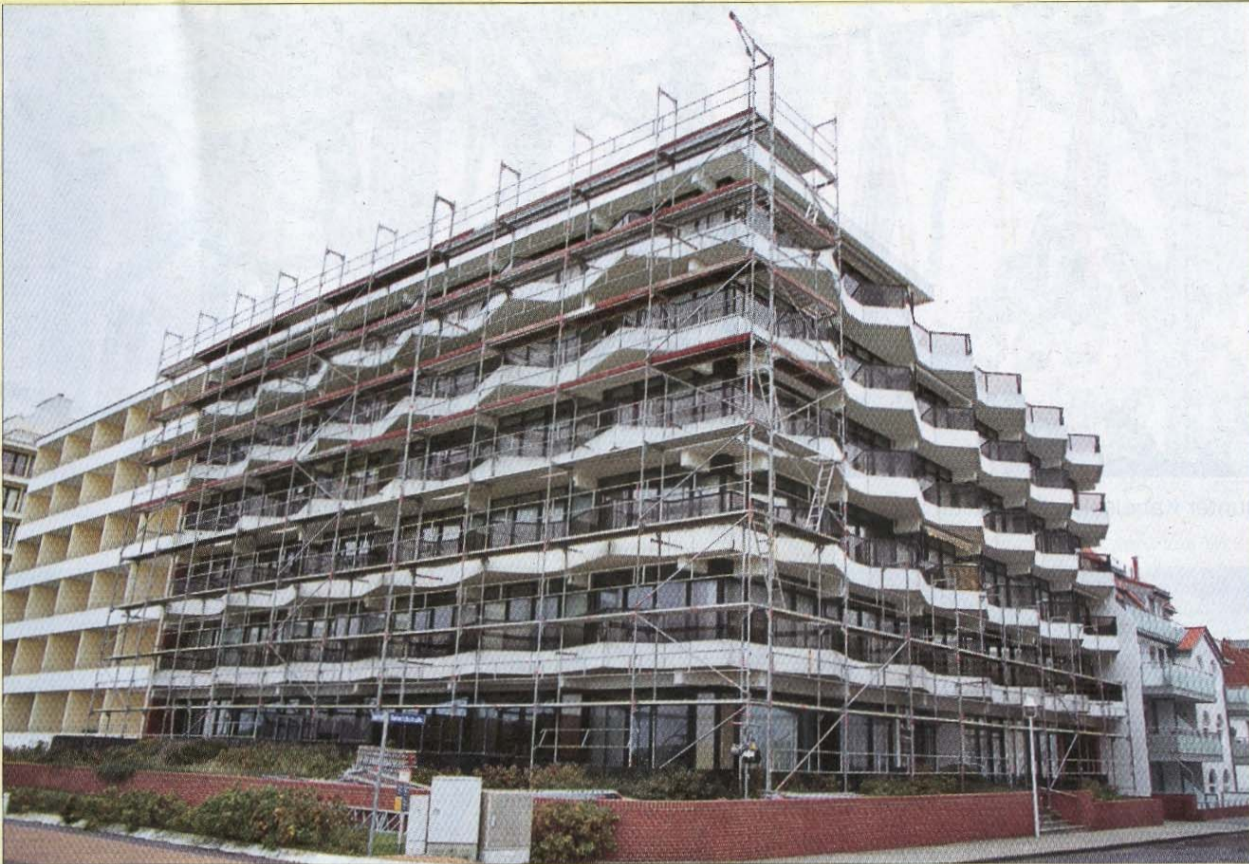
Das Baugerüst an der Ecke Kaiserstraße/Heinrichstraße verrät, dass hier an der Fassade gewerkelt wird.
