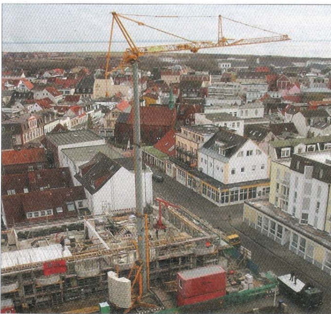
Schlechte Zeiten für Wandergesellen. Zurzeit ist keine Bautätigkeit auf Norderney, wie hier am „Düsseldorfer Hof“. ARCHIVFOTO
