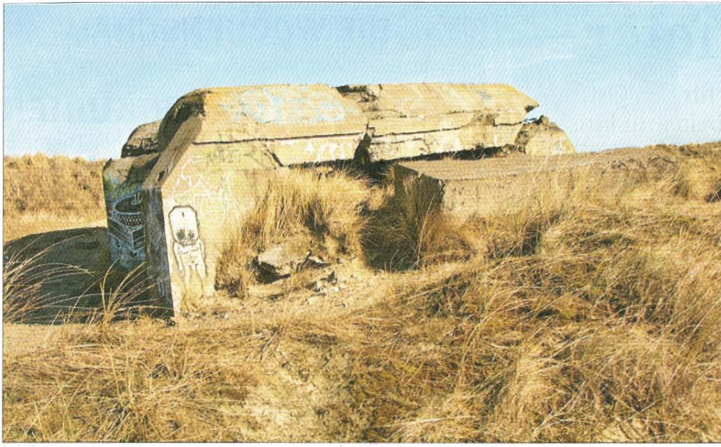
Bunker einer Strand-Batterie in der Schutzdünenkette am Nordstrand.
