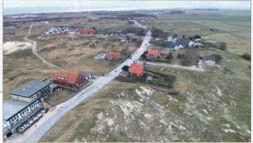
Der Blick Richtung Osten lässt die Straßenbaustelle sowie die zahlreichen Campingplätze im Inselosten gut erkennen.
