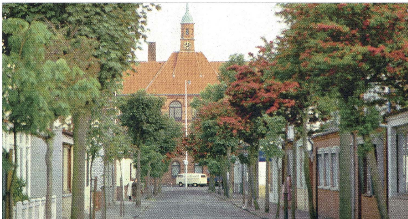
Der Ist-Zustand, von der Schulzenstraße aus gesehen.
