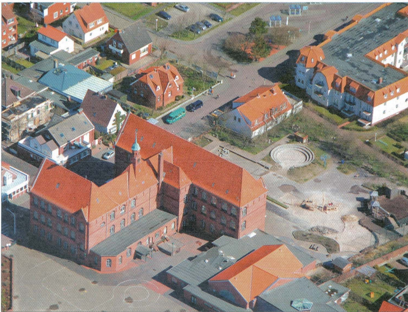
Die Grundschule Norderney, ein stadtbildprägendes Gebäude an der Jann-Berghaus-Straße.
