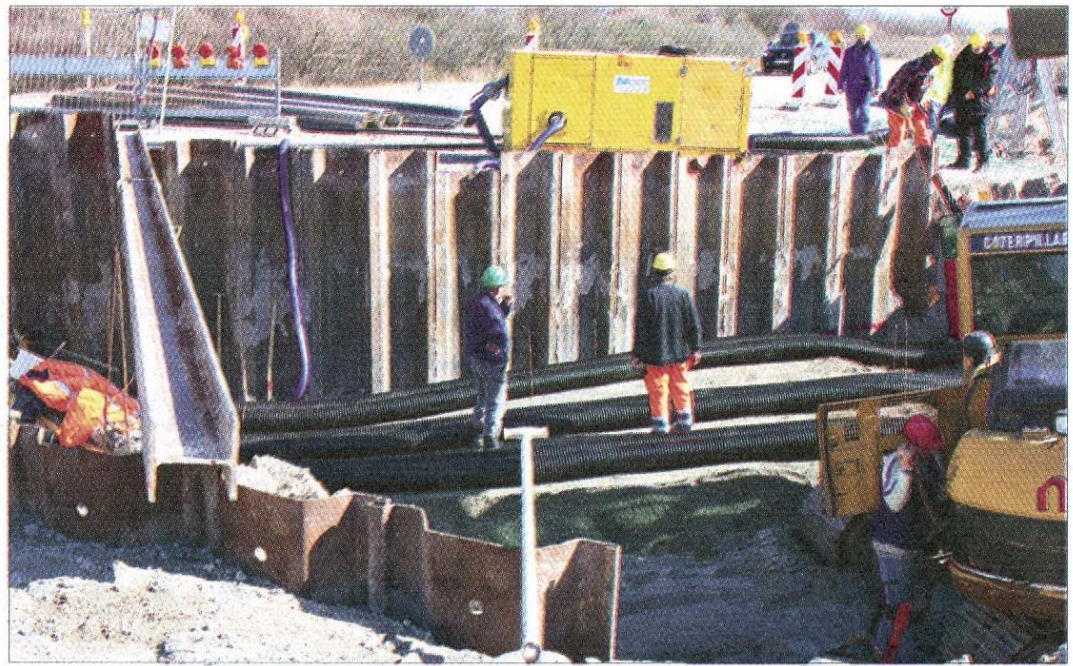
Verlegung von Leerrohren für die Offshorekabel in einer Straßenkreuzung heute.
