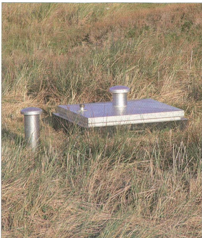
Kopf eines Förderbrunnens in den Dünen am Wasserwerk II.
