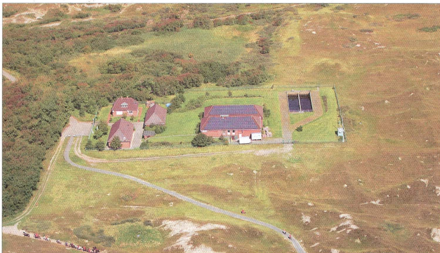
Das Wasserwerk II „Weiße Düne“ in der Inselmitte auf der Höhe des Leuchtturms.
