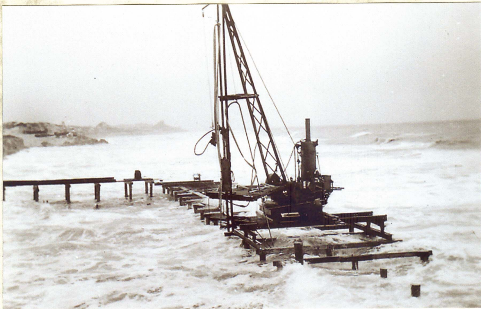
Rammgerüst bei Flut. 04.07.1949
