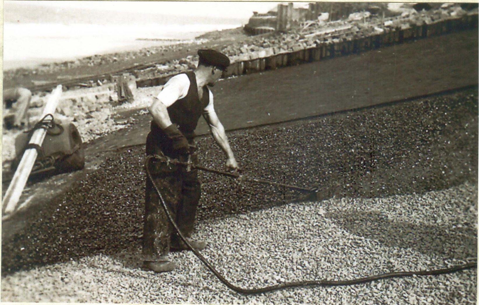
Tränken der Splittschicht mit heißem Bitumen. 19.09.1949
