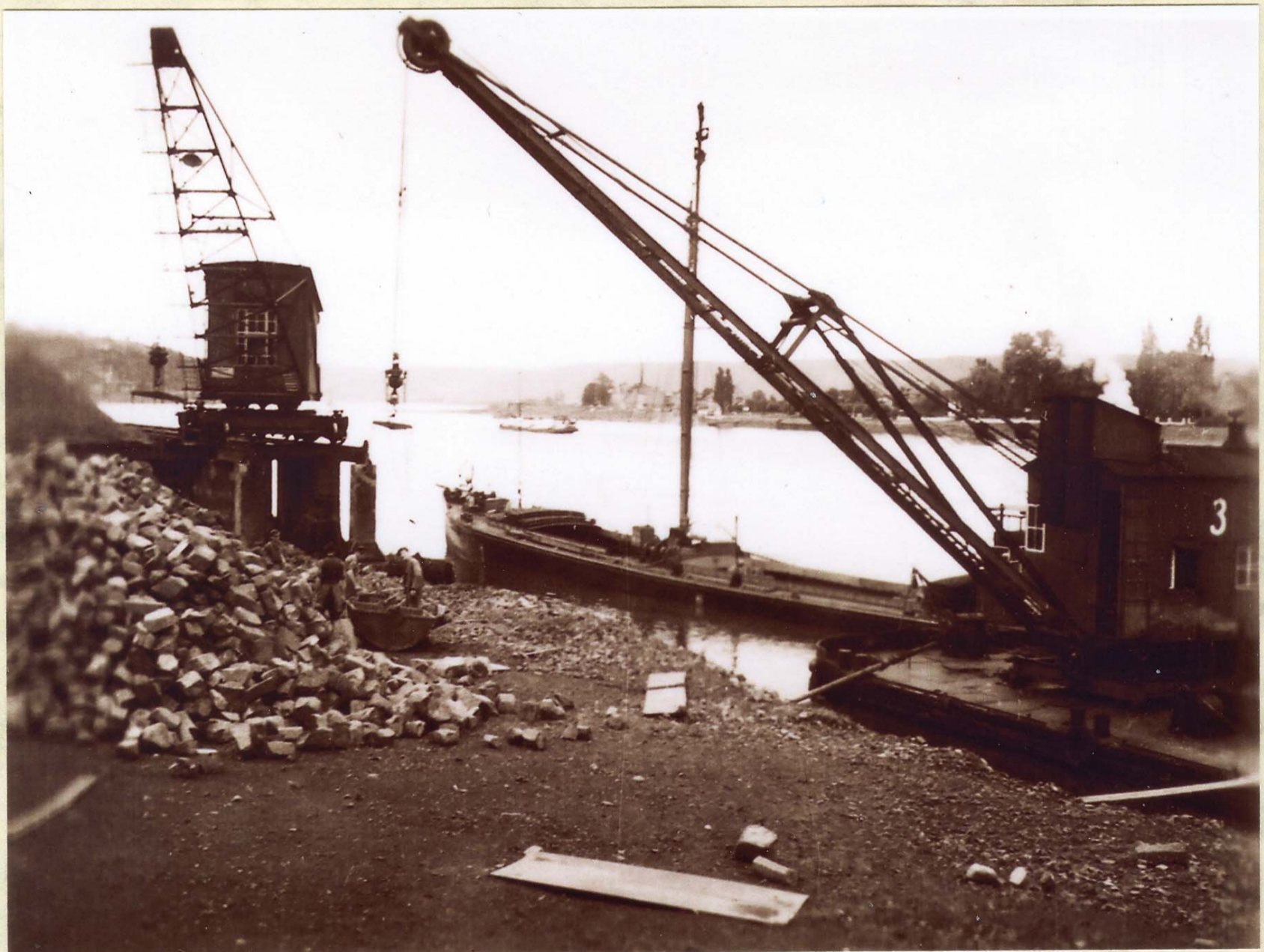
Das Bild zeigt eine Verladestelle bei Linz am Rhein. Mit solchen Schiffen wurde der Basalt auch nach Norderney transportiert. Genau wie verladen wurde das Schiff im Norderneyer Hafen wieder entladen. Mit LKWs ging es dann zur Baustelle.
