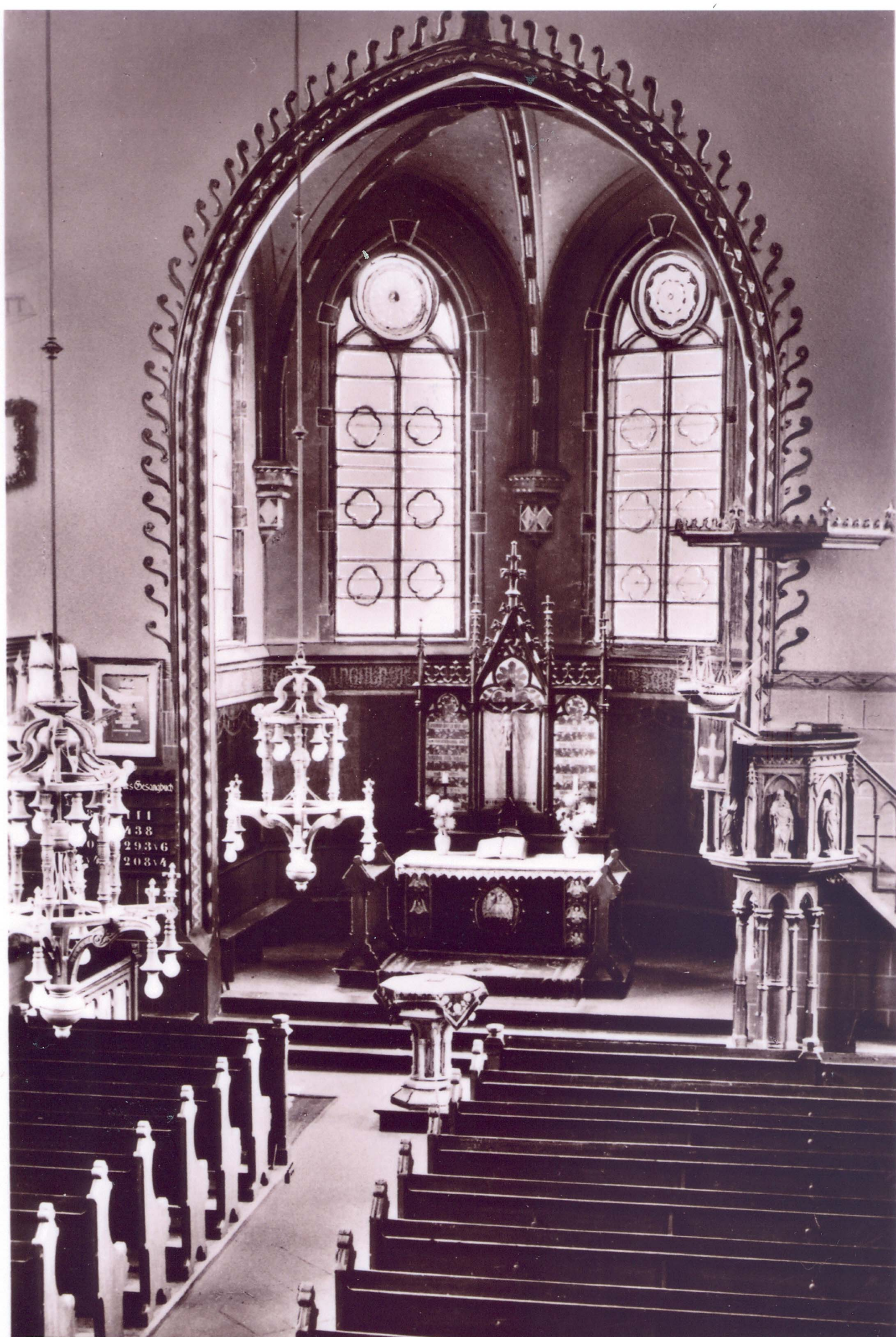
Innenansicht der Inselkirche um 1910. Die vorher mit Petroleumlampen benutzten Hängeleuchten wurden, nach dem auch der Strom auf Norderney Einzug gehalten hat, mit elektrischen Birnen umgebaut. Die Leuchten waren aus hellem Eichenholz gebaut.
