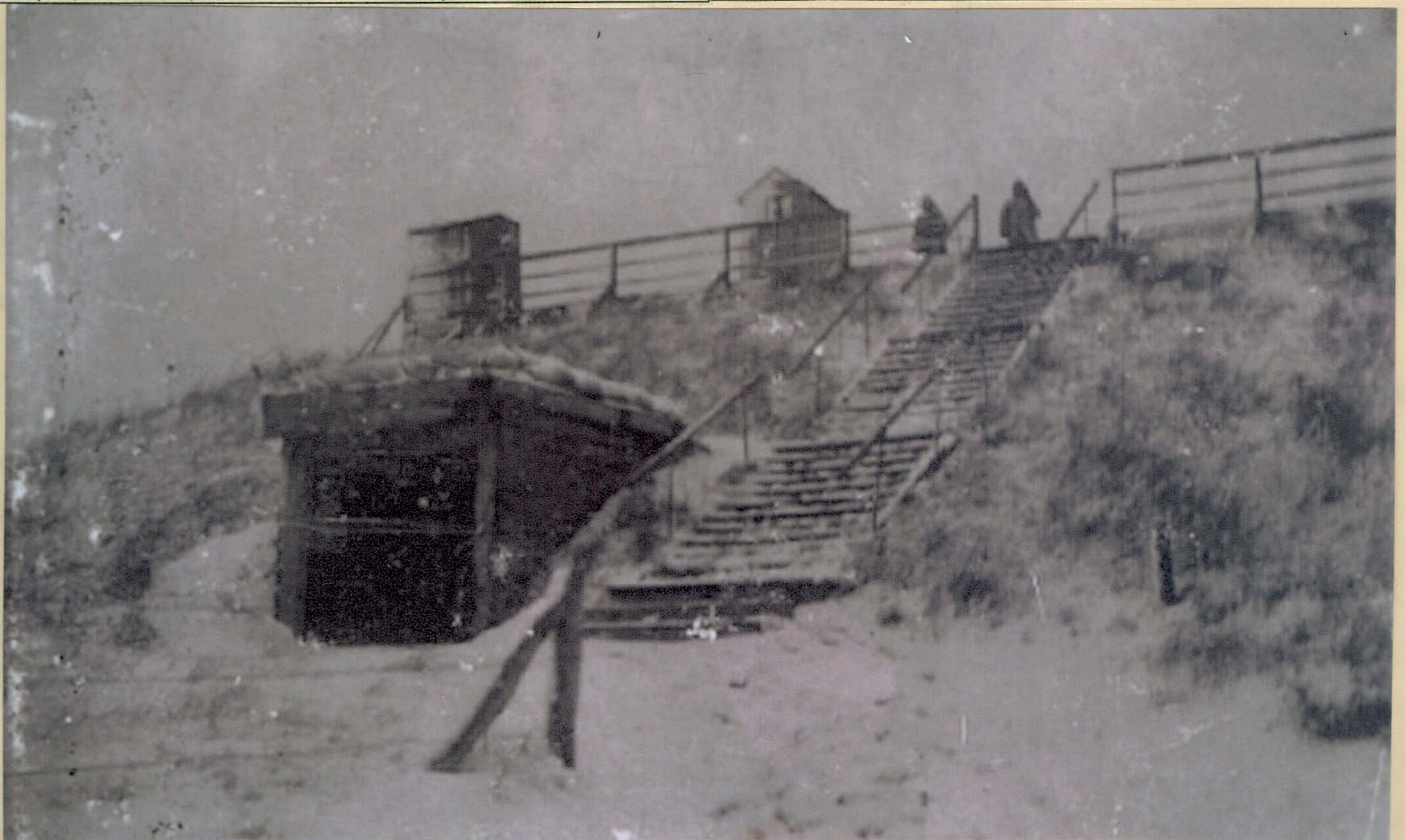
Der Ausgang zur Plattform war an der Südseite der Georgshöhe neu verlegt worden. Auch ein großer Munitionsbunker wurde neben der Treppe angelegt. Links oben im Bild, auch eine alte Badekutsche, diente als Schutzhütte für das schwere MG gegen Witterungseinflüsse. Bei Alarm wurde es dann auf dem hölzernen Podest schnell aufgebaut. Den Wachdienst führten immer 2 Mann der Horderneper - Inselwache aus..
