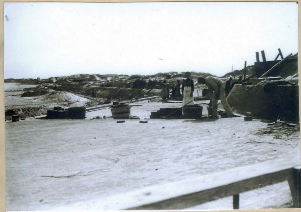
1858 Im Gegensatz zur Wandelbahn vom Weststrand bis zum Januskopf, die mit Balsatin- (Granit)Platten belegt waren, wurde die Wandelbahn vom Januskopf bis Cornelius mit Klinkersteinen in Zementmörtel verlegt. Auch eine kleine Schutzmauer, rechts im Bild, wurde aus roten Klinkersteinen angefertigt.
