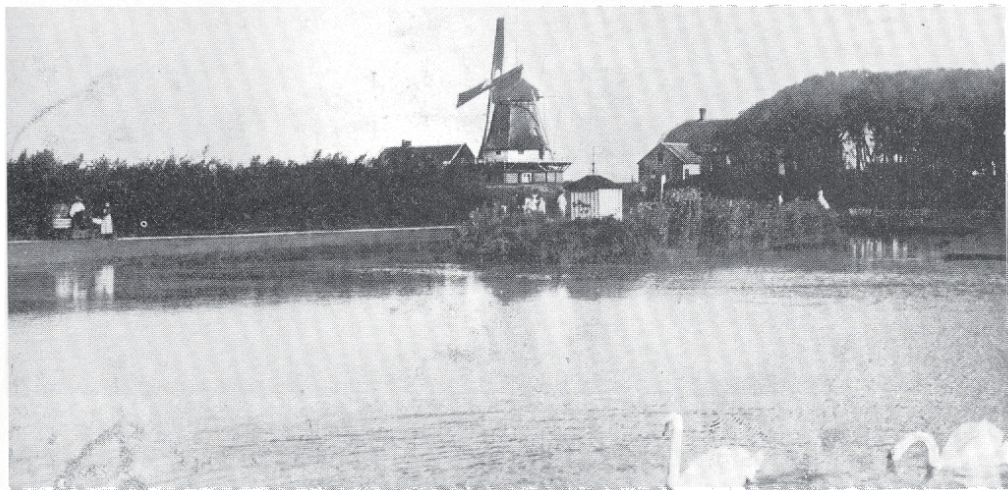
Windmühle mit dem alten Schwanenteich
