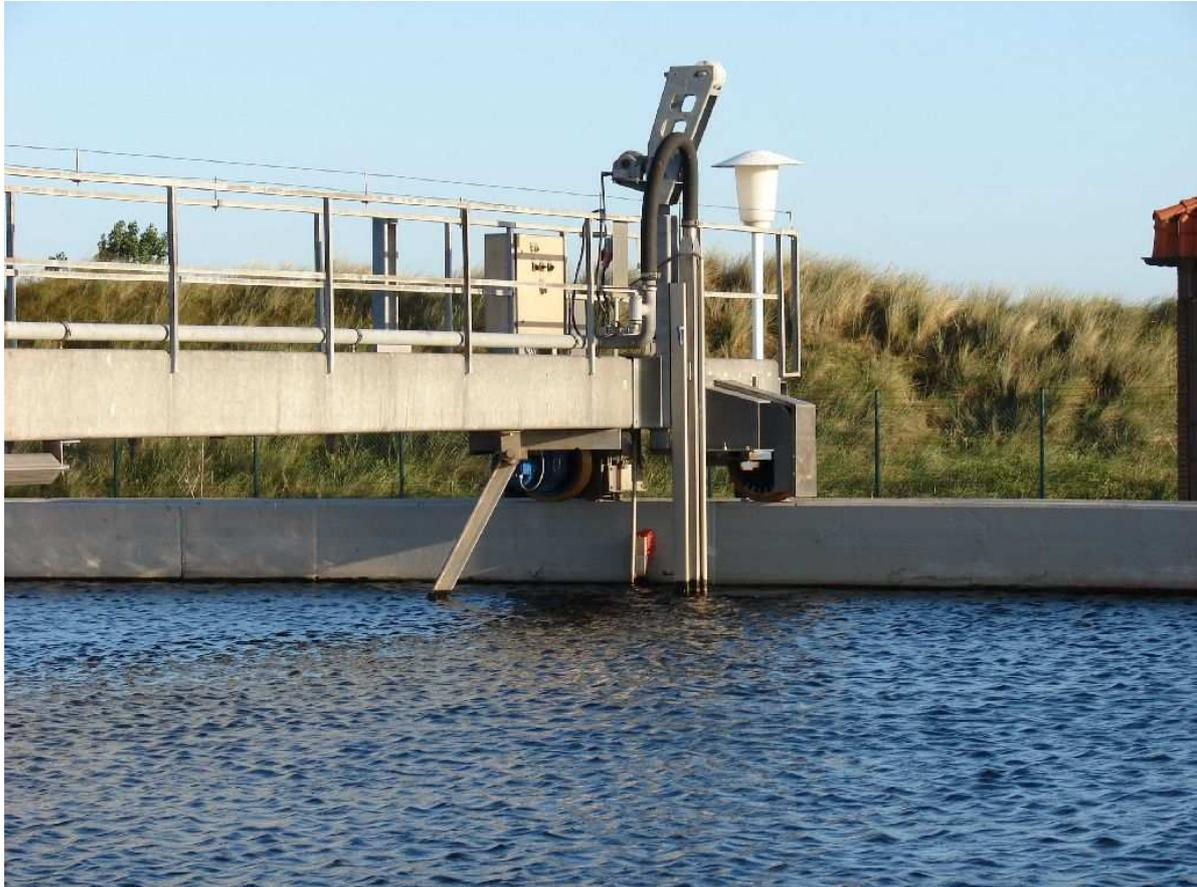
Nach einer bestimmten Aufenthaltszeit in der Belebungsstufe, fließt der belebte Schlamm in die Nachklärbecken. Dort setzt er sich am Boden ab und wird durch ein Räumschild in die Schlammtasche befördert. Von dort ziehen die Rücknahmeschneckenpumpen die konzentrierte Biomasse in das Verteilerbauwerk ab, wo es je nach eingestelltem Trockensubstanzgehalt in Überschussschlamm und Rücklaufschlamm zur Weiternutzung geteilt wird.
