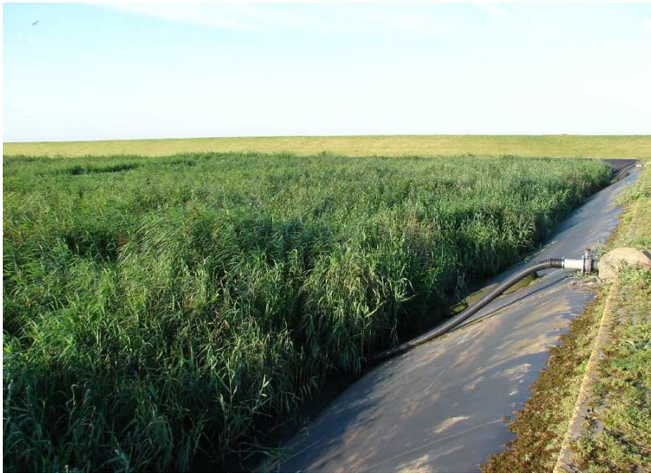
In den Schilfbeeten verbleibt eine eingedickte schlammige Suspension. Die adaptierten Schilfpflanzen entziehen dem Schlamm über die Wurzeln weiteres Wasser und verdunsten es kontinuierlich, je nach Jahreszeit mehr oder weniger stark. Doch schon jetzt hat der Schlamm ungefähr soviel Wasser verloren wie bei der technischen Entwässerung, jedoch mit minimalem Aufwand an Primärenergie, Zeit und Kosten, komplett ohne teure Zusatzstoffe wie Entwässerungshilfsmittel oder Kalk.
