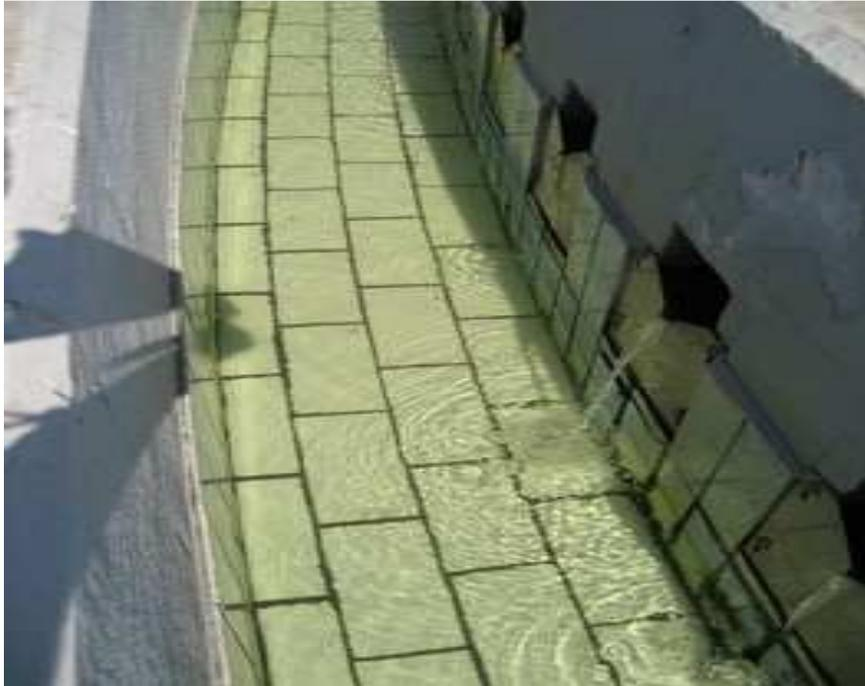
Das geklärte Abwasser sammelt sich in einer Rinne und läuft über die Ablaufmessung zum Auslaufbauwerk direkt in die Teiche im Südstrandpolder.
