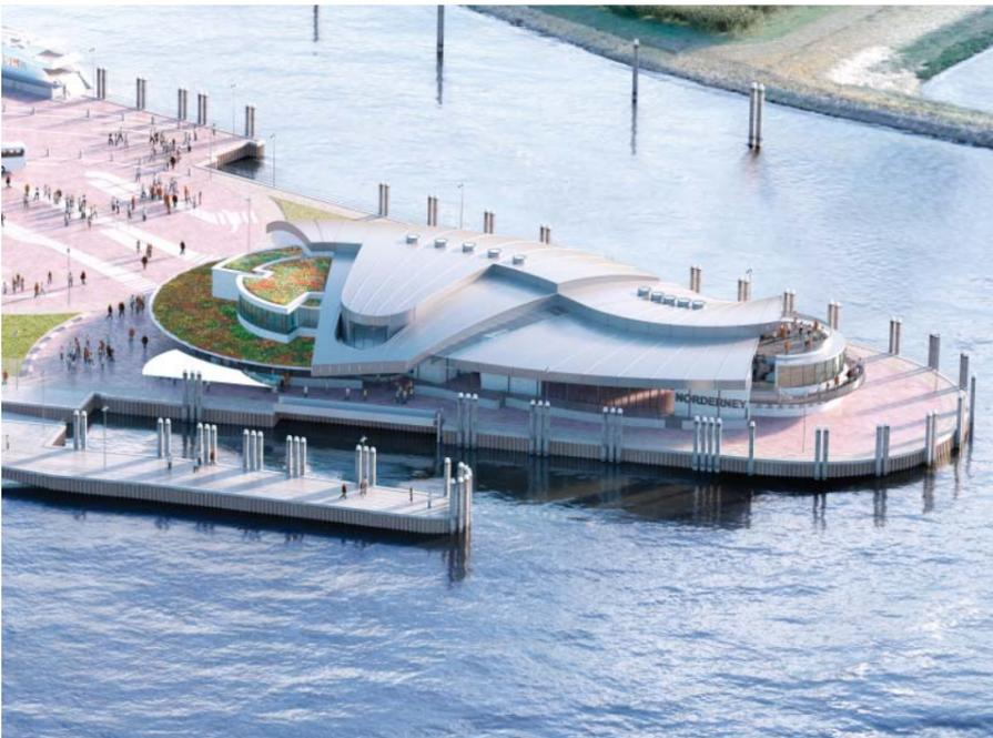
über eine flache, schalenförmige Dachkonstruktion an sanft geschwungene Dünen erinnern soll. Das Gebäude wird vollüberdachten Zugang zu den Fährbrücken bieten.
