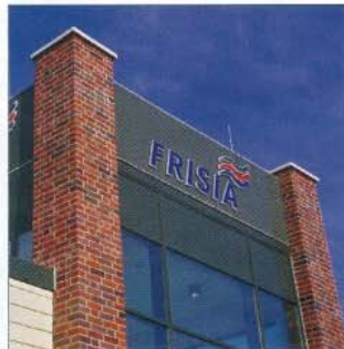
Der „Turm“ des West-Terminals.
