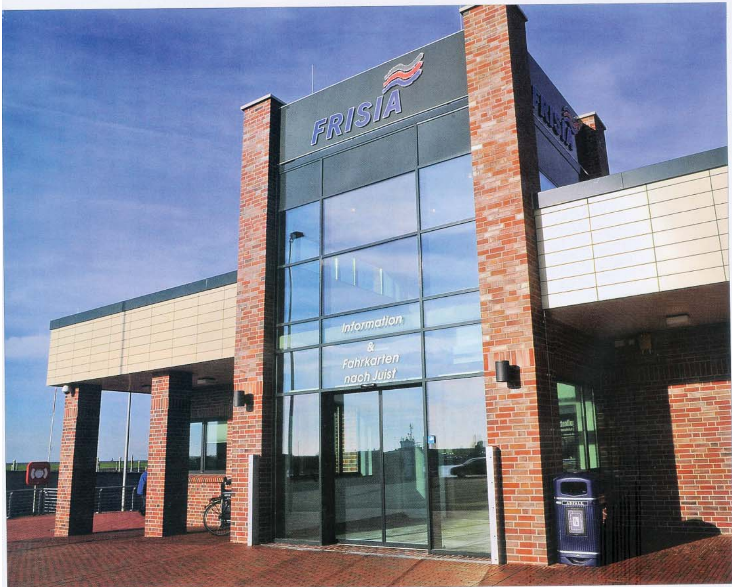
Der neue Eingang des West-Terminals.
