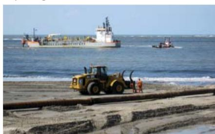
Norderney liegenden „Robbenplate“. Im Jahr 2012 hat erstmals ein so genannter Laderaumsaugbagger oder Hopperbagger den Sand aus der Entnahmestelle in seinen Laderaum aufgesaugt und damit zur Koppelstation gefahren, die vor den Bühnen zwischen Milchbar und Moltkestraße liegt.
