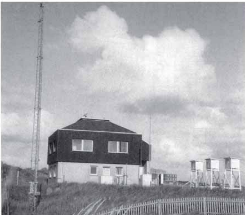
Die Wetterstation Norderney. Sie wurde abseits der städtischen Bebauung errichtet, um das Inselklima möglichst ungestört zu erfassen.
